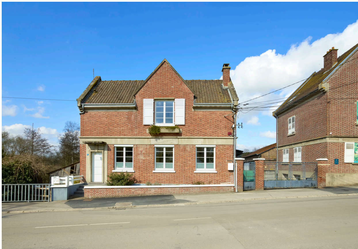
Vue de la maison, depuis l'ouest.
