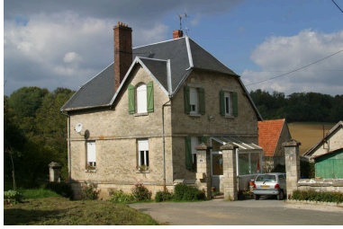
Vue générale. Phot. Inès Guérin IVR22_20030202321NUCA
