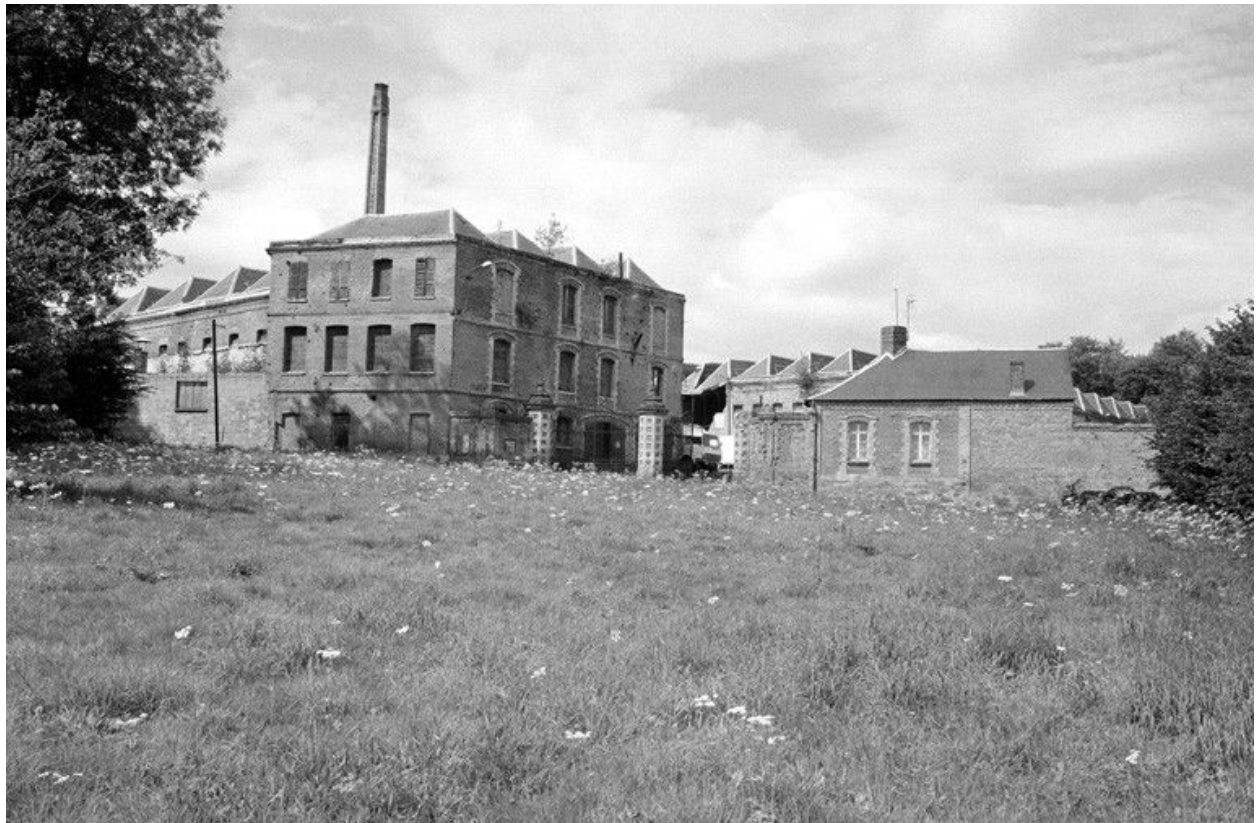
Vue générale, flanc est.
