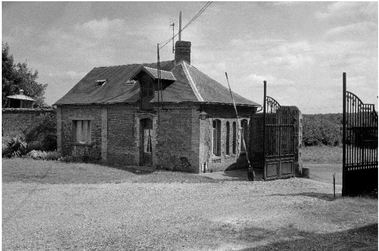
Conciergerie, élévation antérieure.
