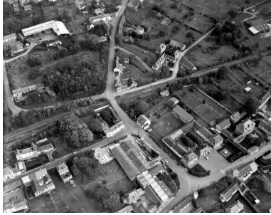
Vue aérienne, flanc sud. Phot. Phot'R IVR22_19888001511P
