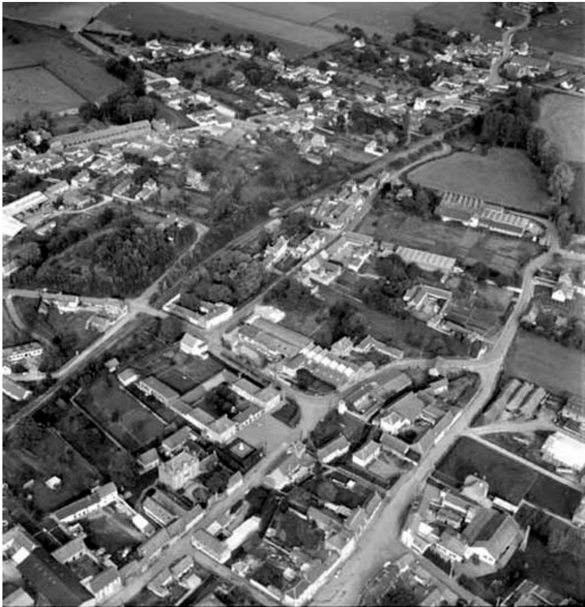
Vue aérienne, flanc ouest.
