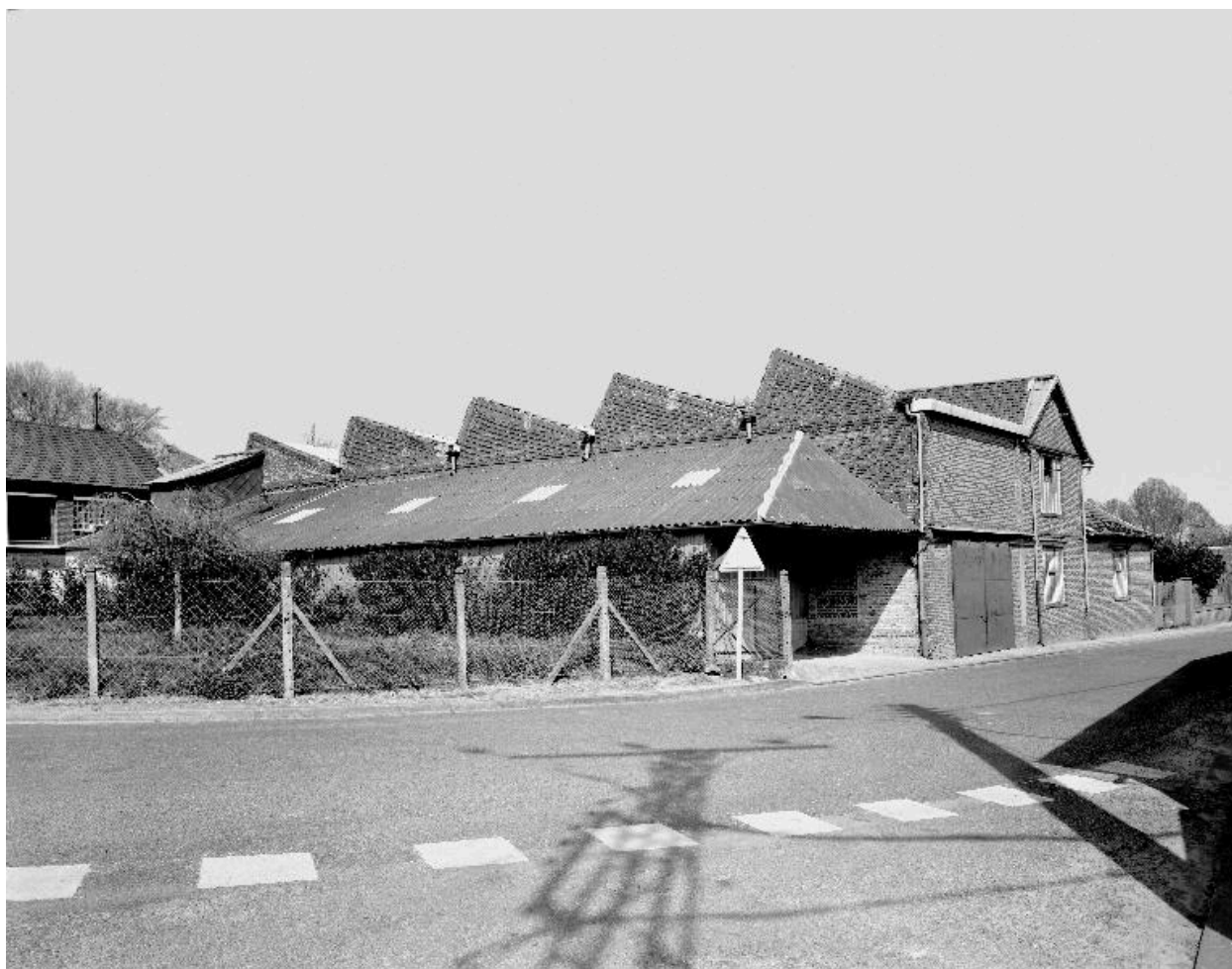
Atelier de fabrication, flanc ouest.
