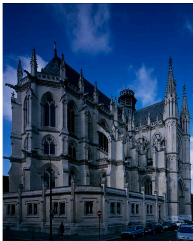
Amiens. Eglise Saint-Remy (Paul Delefortrie architecte). Phot. Thierry Lefébure IVR22_20038000386VA
