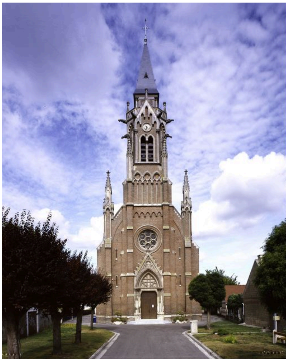
Saleux. Eglise paroissiale Saint-Fuscien (Victor Louis Delefortrie et fils architecte)
