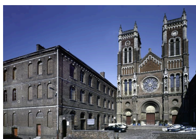
Amiens. Eglise Sainte-Anne (Victor Louis Delefortrie et fils architecte). Phot. Thierry Lefébure IVR22_20058000332PA
