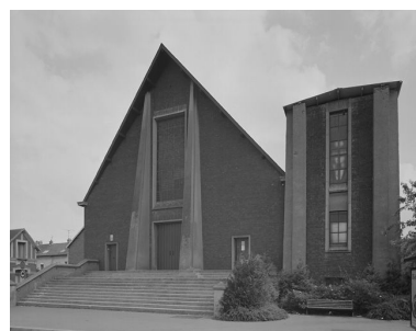
Amiens. Eglise du Coeur- immaculé-de-Marie (Mallet et Carpentier architectes). Phot. Thierry Lefébure IVR22_19968000249V
