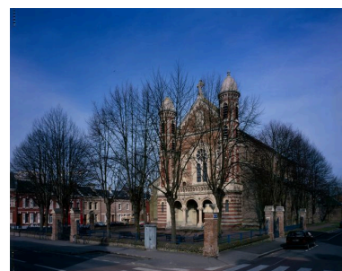
Amiens. Eglise Saint-Roch (Louis Henry Antoine architecte). Phot. Thierry Lefébure IVR22_20038000220VA
