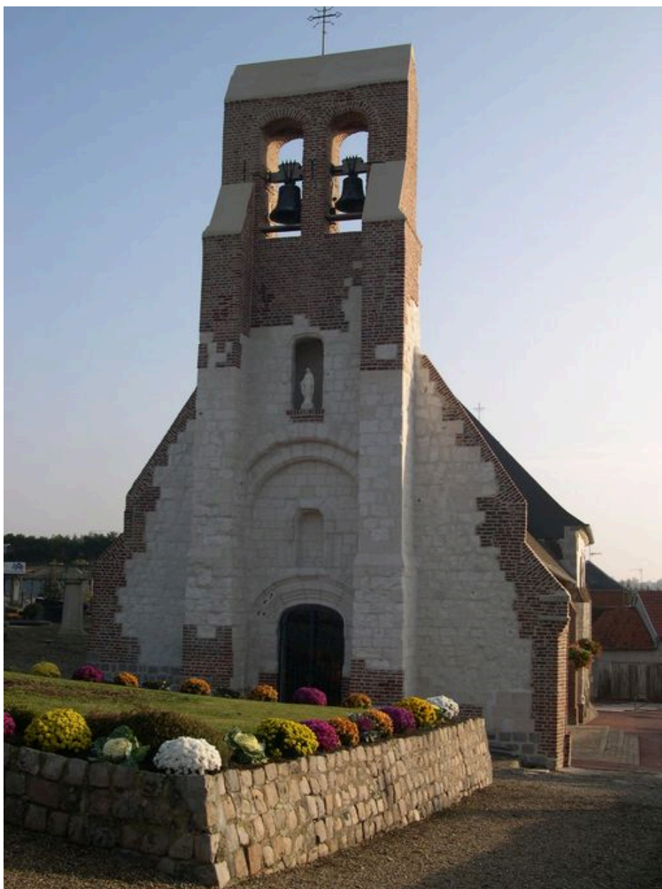
Pont-de-Metz. Eglise paroissiale et cimetière Saint-Cyr et Sainte-Julitte.
