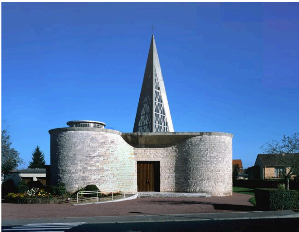
Longueau. Eglise Saint-Médard (Marcel Gogois architecte).
