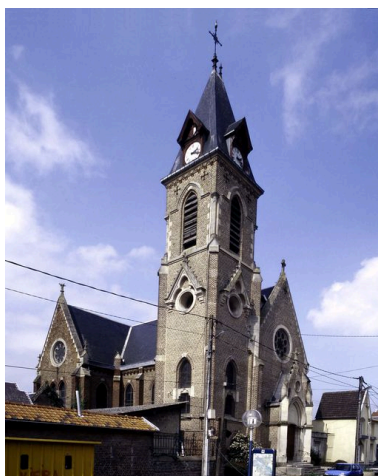
Amiens (Longpré-lès-Amiens). Eglise paroissiale Saint-Léger (Henri Parent architecte). Phot. Thierry Lefébure IVR22_20058000968XA
