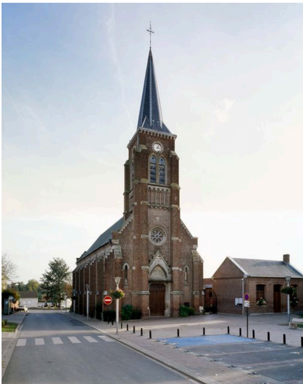
Poulainville. Eglise paroissiale Saint-Pierre (Victor Louis Delfortrie et fils architecte).
