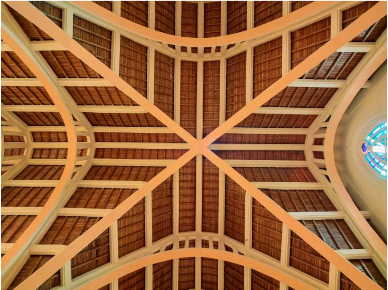
Croisée du transept. Vue zénithale de la charpente.
