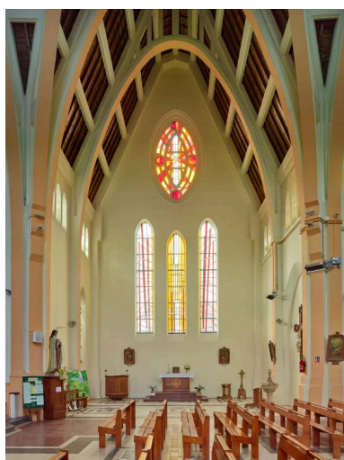
Vue du transept depuis la croisée, vers le nord-ouest. Phot. Pierre Thibaut IVR32_20196200091NUCA
