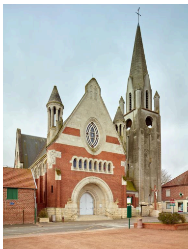
Vue de trois quarts vers l'est. Phot. Pierre Thibaut IVR32_20196200130NUCA
