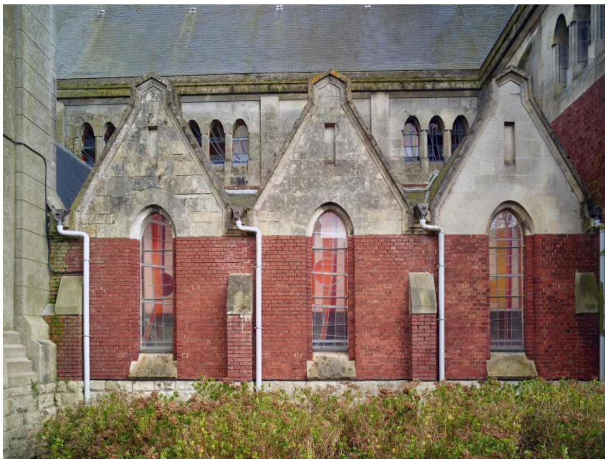
Élévation rue d'Arras. Chapelles.
