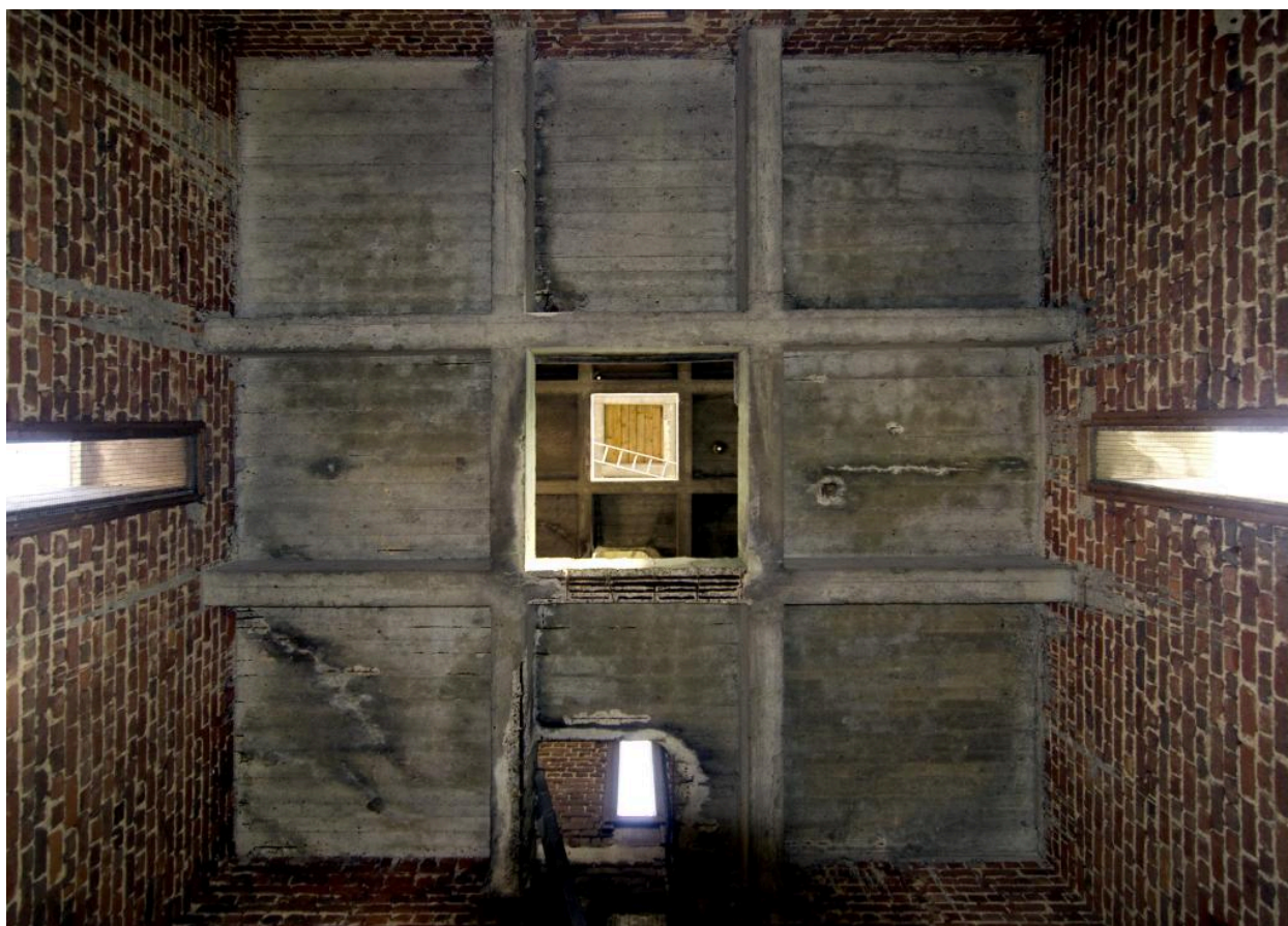
Vue zénithale au travers des planchers en béton armé du clocher.
