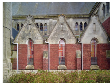
Élévation rue d'Arras. Chapelles. Phot. Pierre Thibaut IVR32_20196200071NUCA
