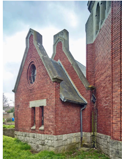
Sacristie vers l'ouest. Phot. Pierre Thibaut IVR32_20196200080NUCA
