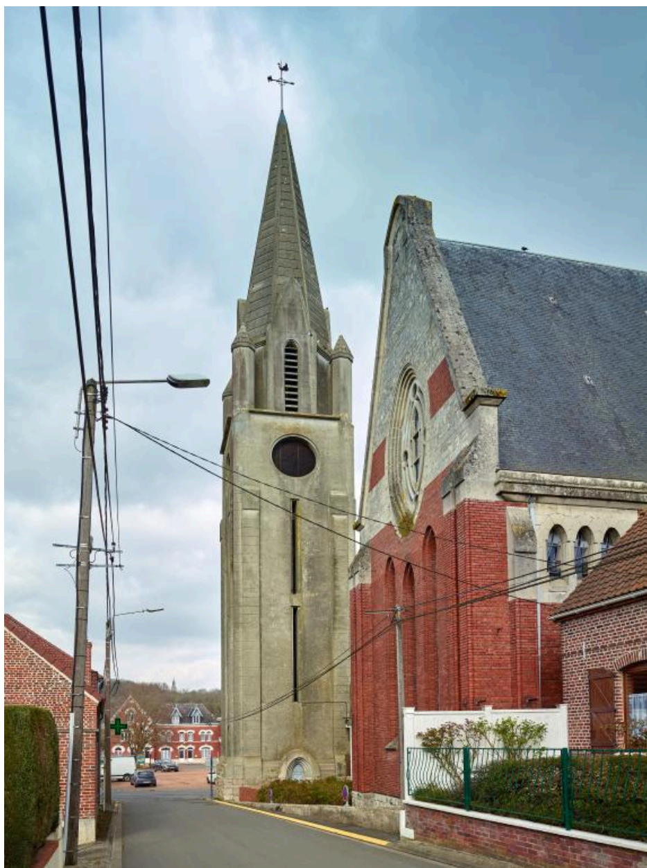
Clocher et transept depuis la rue d'Arras, vers le nord-est.
