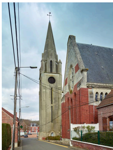
Clocher et transept depuis la rue d'Arras, vers le nord-est. Phot. Pierre Thibaut IVR32_20196200072NUCA
