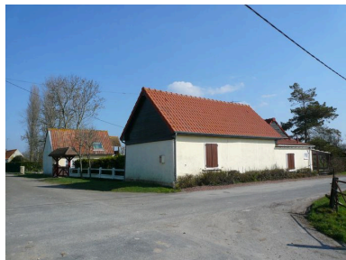
Vue d'ensemble. Phot. Inès Guérin IVR22_20078005501NUCA
