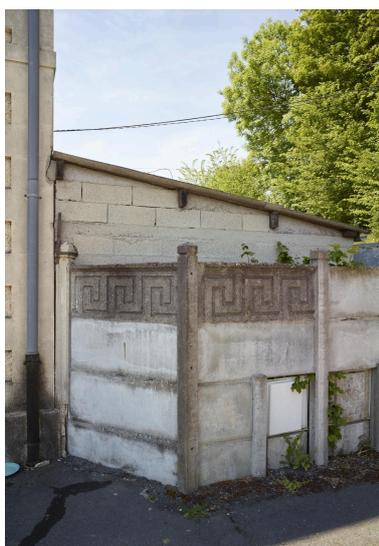
Détail de la palissade en béton
