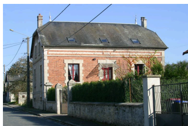
Vue générale de la maison sise au 8 rue du Château à Ostel.
