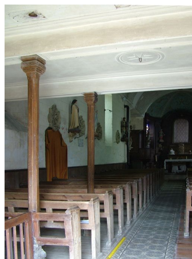
Vue des piliers de bois soutenant les poutres. Phot. Frédéric Fournis IVR22_20098005344NUCA
