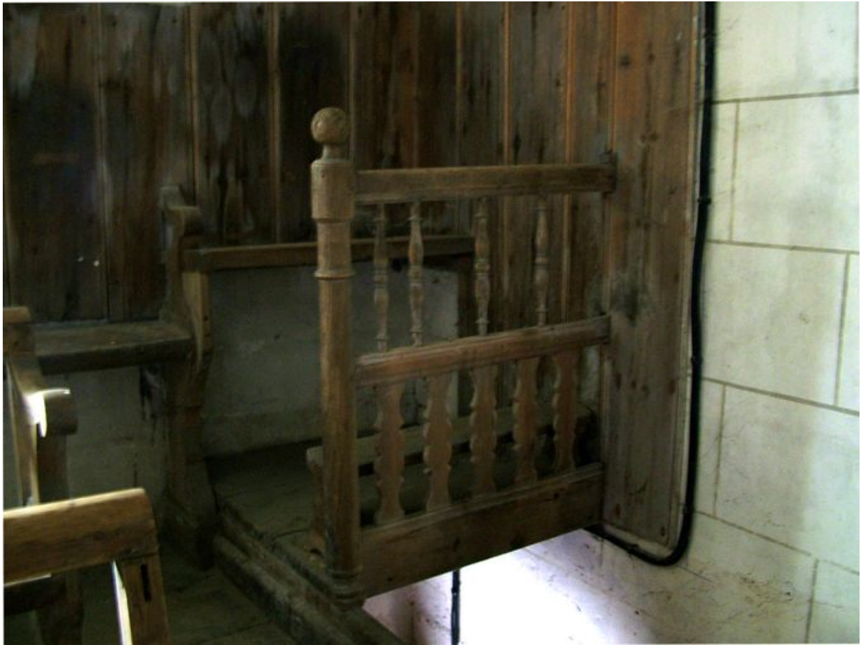
Petite tribune surplombant l'escalier.
