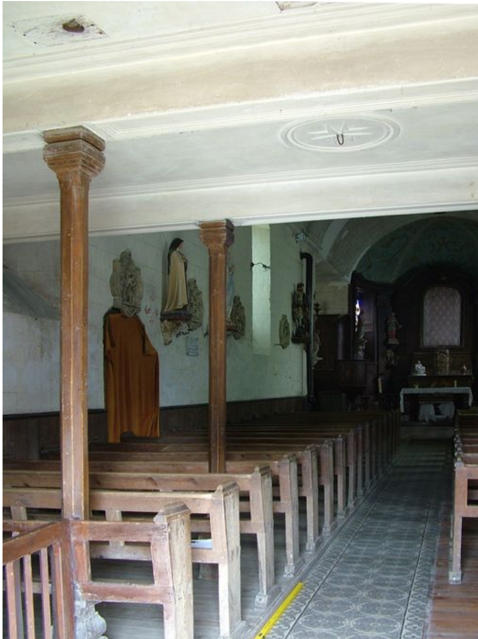
Vue des piliers de bois soutenant les poutres.
