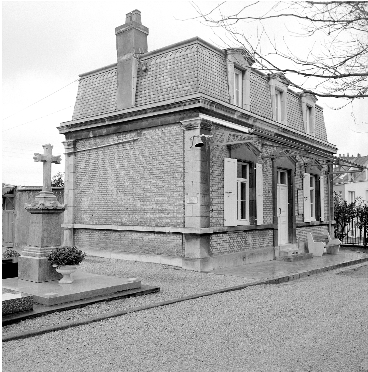
Vue d'angle sud en 1994.
