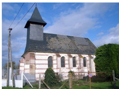
Vue depuis le sud. Phot. Inès Guérin IVR22_20078005971NUCA
