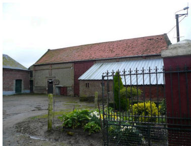
Vue de la grange. Phot. Inès Guérin IVR22_20078005555NUCA
