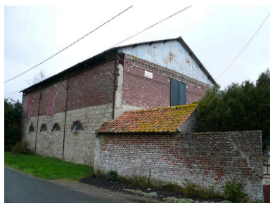
Vue des étables depuis la rue. Phot. Inès Guérin IVR22_20078005557NUCA
