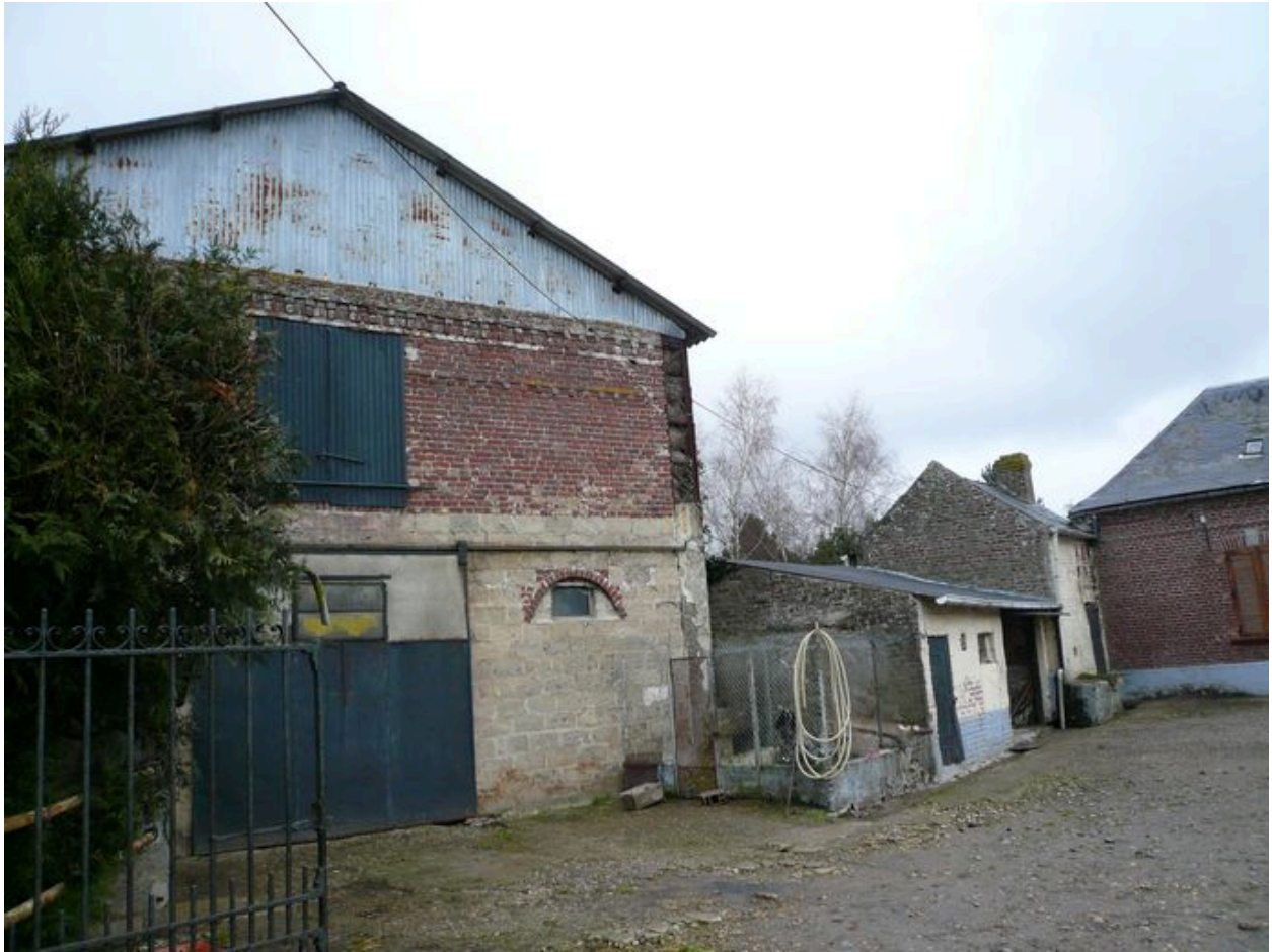
Vue des porcheries, fournil et étables sur rue.
