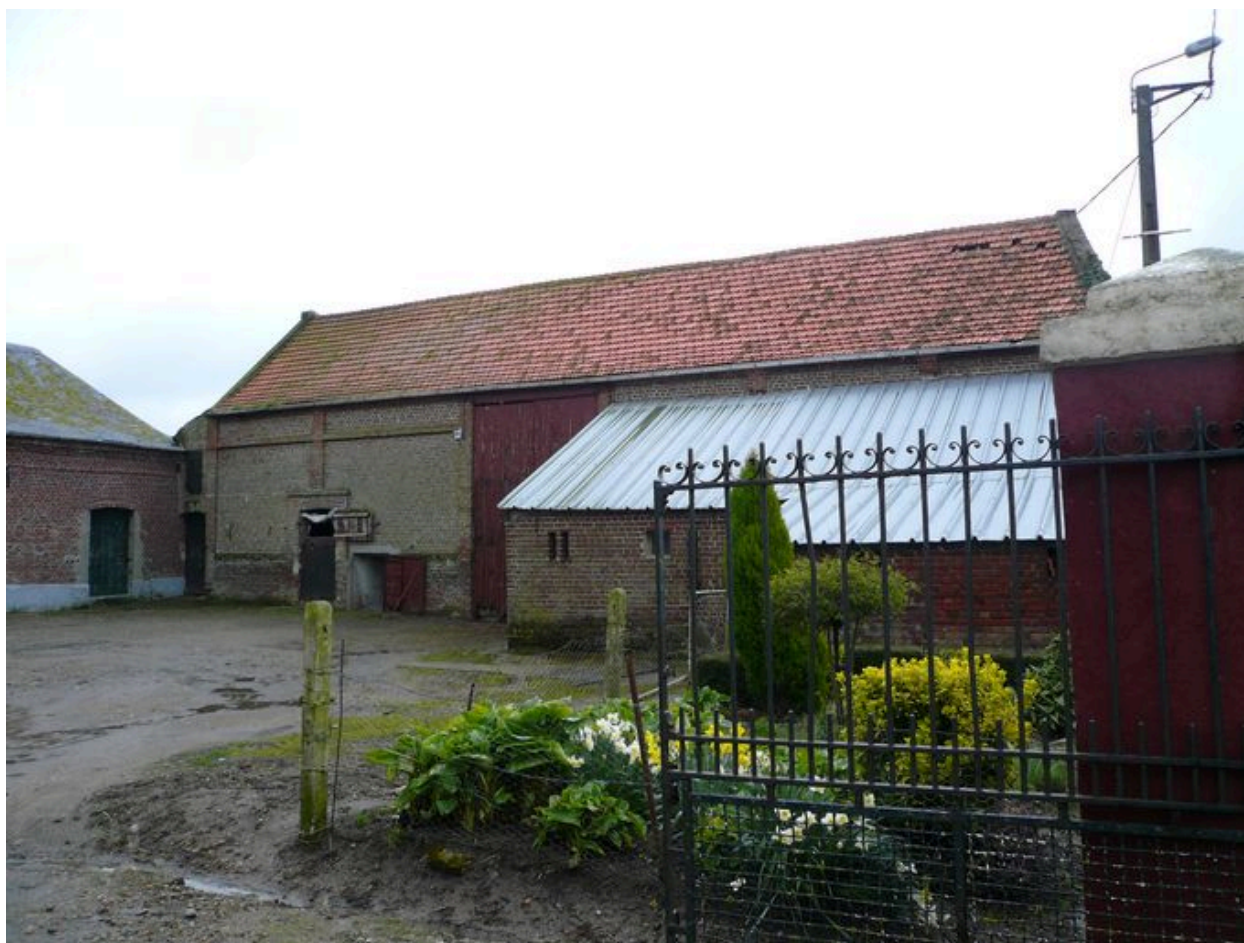
Vue de la grange.
