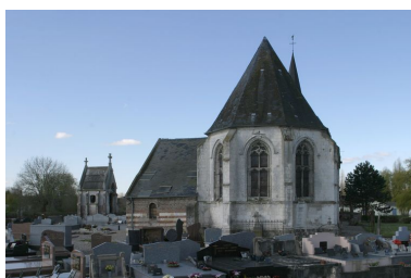
Vue du chevet. Phot. Irwin Leullier IVR22_20078000140NUCA
