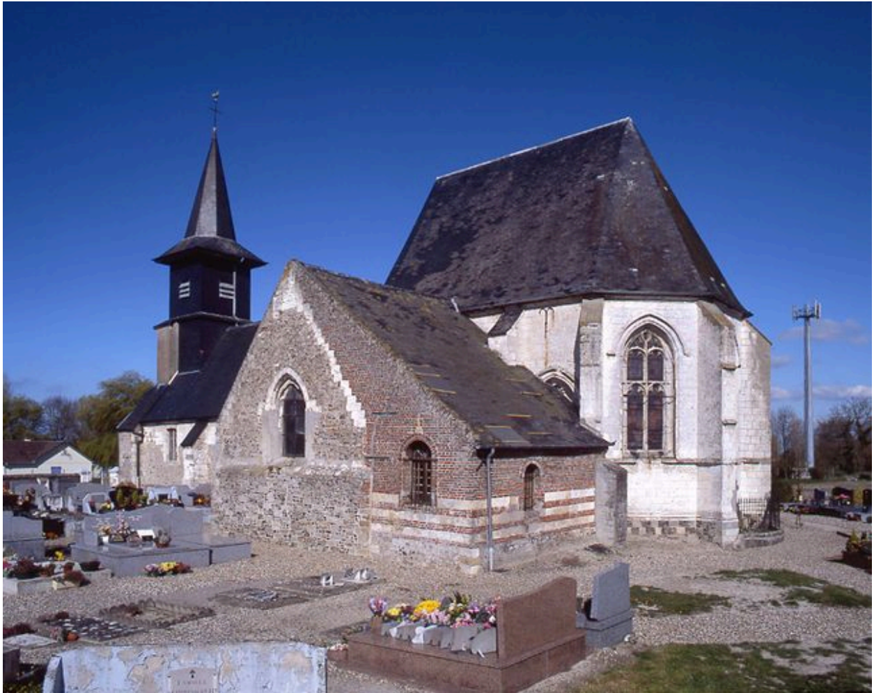
Vue depuis le sud-est.
