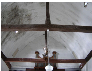
Vue des fermes de la charpente. Phot. Inès Guérin IVR22_20078005950NUCA
