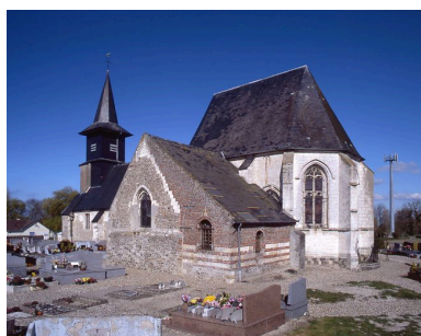
Vue depuis le sud-est. Phot. Irwin Leullier IVR22_20078000093XA
