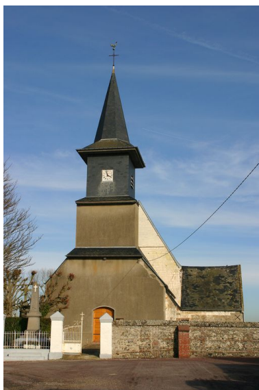
Vue générale de la face ouest. Phot. Irwin Leullier IVR22_20078000141NUCA
