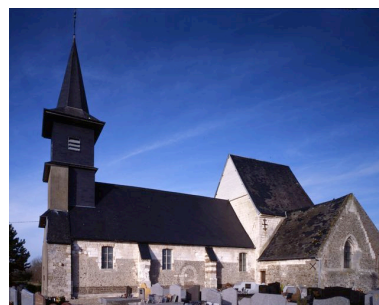
Vue depuis le sud-ouest. Phot. Irwin Leullier IVR22_20078000094XA
