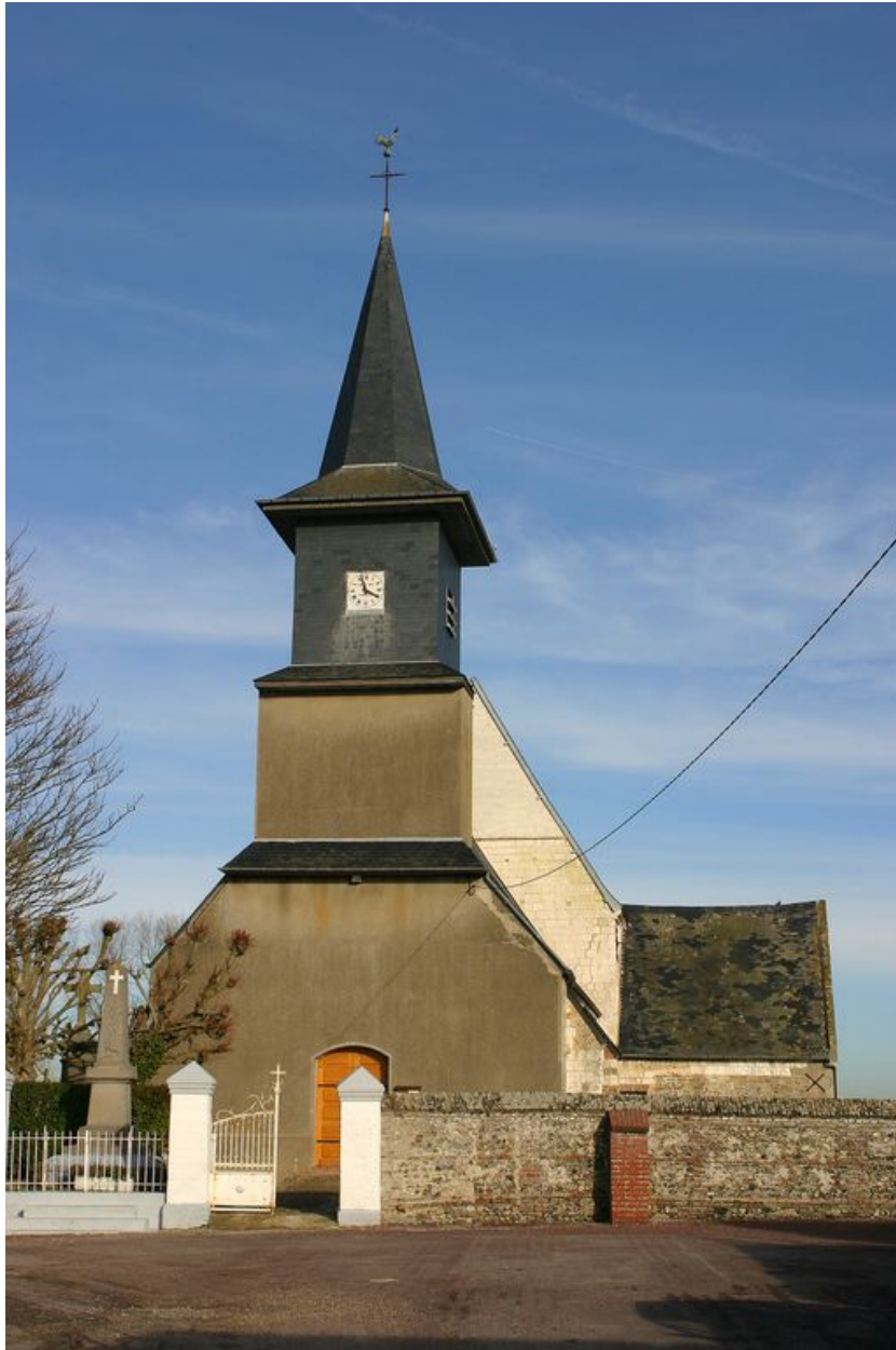
Vue générale de la face ouest.
