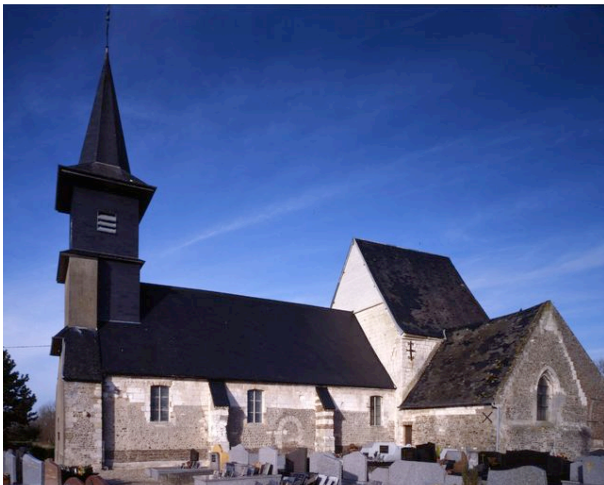
Vue depuis le sud-ouest.
