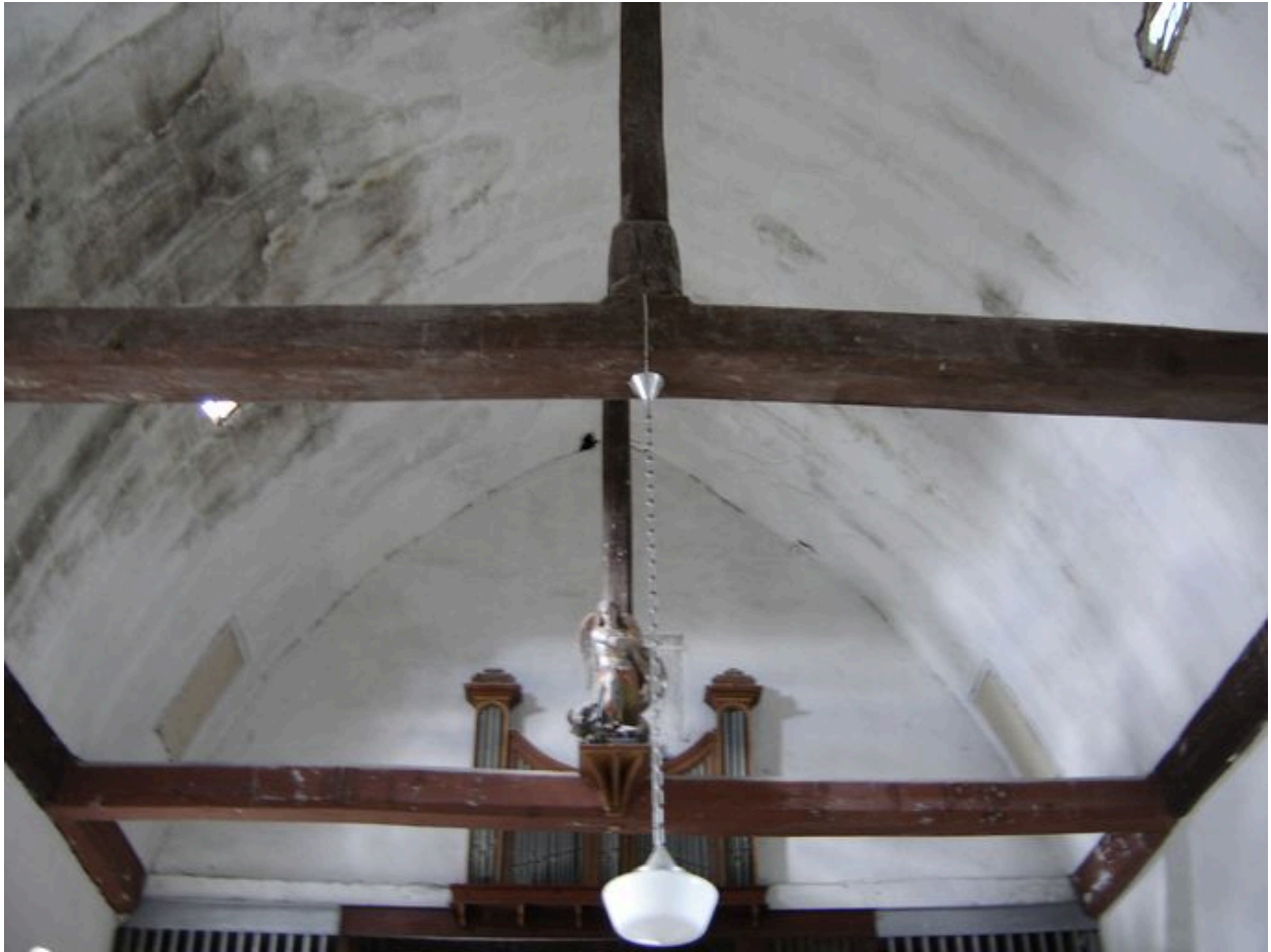
Vue des fermes de la charpente.
