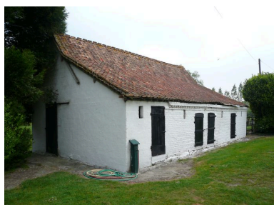
Vue des étales à cochons. Phot. Inès Guérin IVR22_20078005826NUCA
