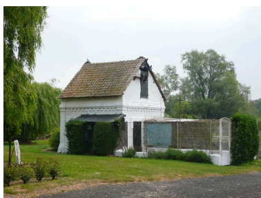
Vue du pigeonnier. Phot. Inès Guérin IVR22_20078005827NUCA
