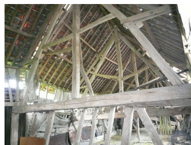
Vue intérieure de la partie grange. Phot. Inès Guérin IVR22_20078005825NUCA
