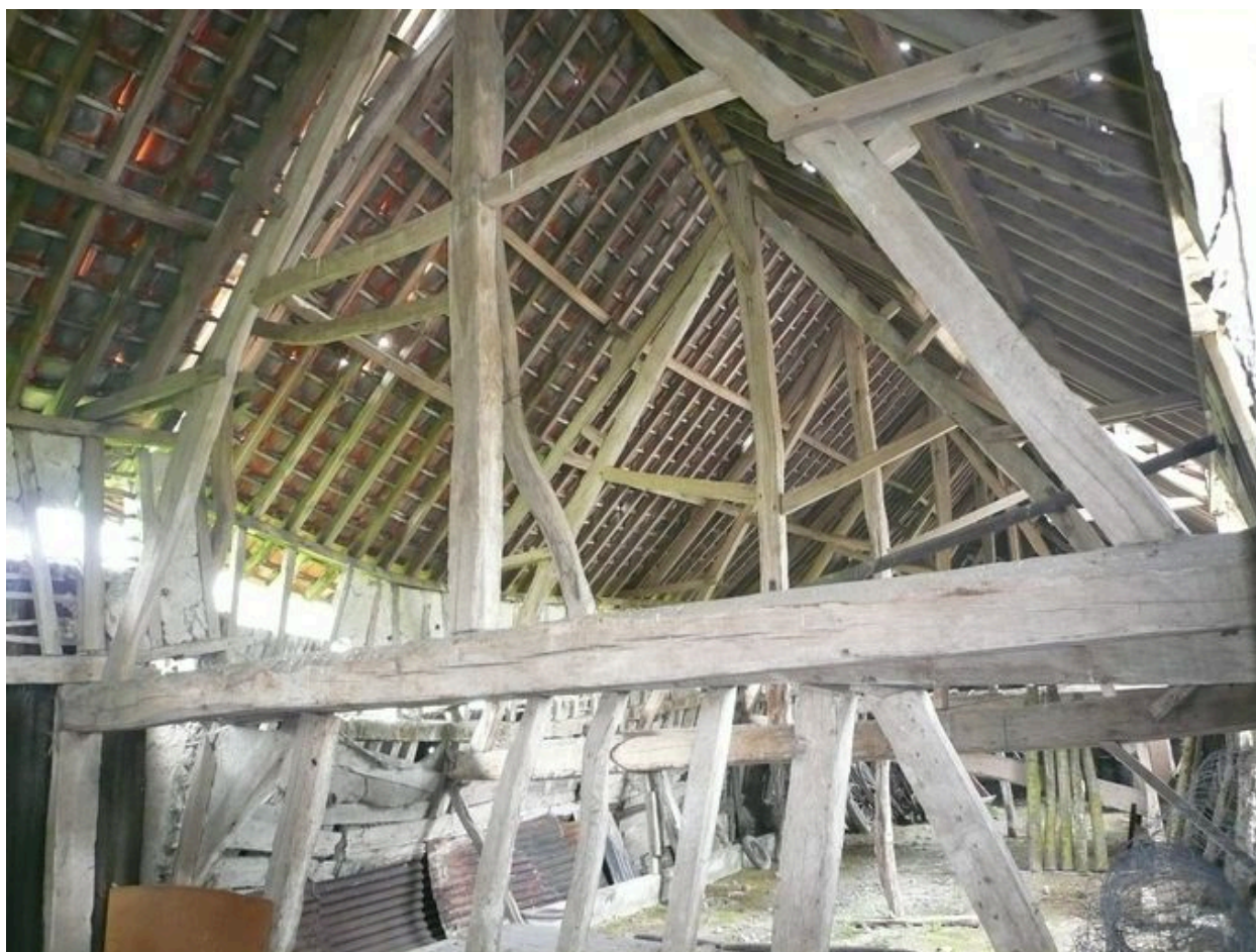
Vue intérieure de la partie grange.
