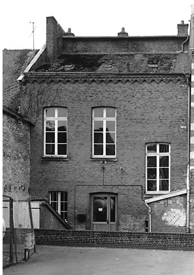
Façade postérieure. Phot. Franck Bürjes IVR22_19990200705X
