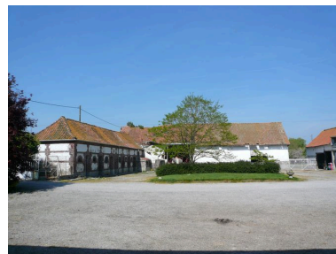
Vue des porcheries le long de la rue (à l'ouest) et de la grange au nord. Phot. Inès Guérin IVR22_20078005733NUCA
