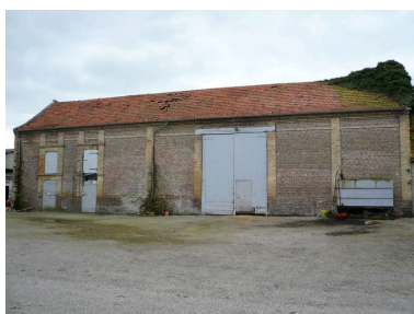
Vue de la seconde grange au sud de la cour. Phot. Inès Guérin IVR22_20078005735NUCA
