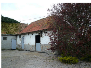
Vue de la bergerie au sud-ouest de la cour. Phot. Inès Guérin IVR22_20078005737NUCA
