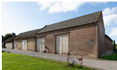
Deux anciennes granges sur la rue, n°2 de la rue de Breteuil, vue depuis le nord-est. Phot. Marc Kérignard IVR32_20246001268NUCA
