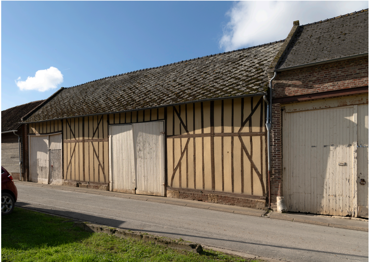
Grange en pan-de-bois hourdé de torchis, n°2 de la rue de Breteuil, vue depuis l'est.
