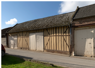
Grange en pan-de-bois hourdé de torchis, n°2 de la rue de Breteuil, vue depuis l'est. Phot. Marc Kérignard IVR32_20246001266NUCA
