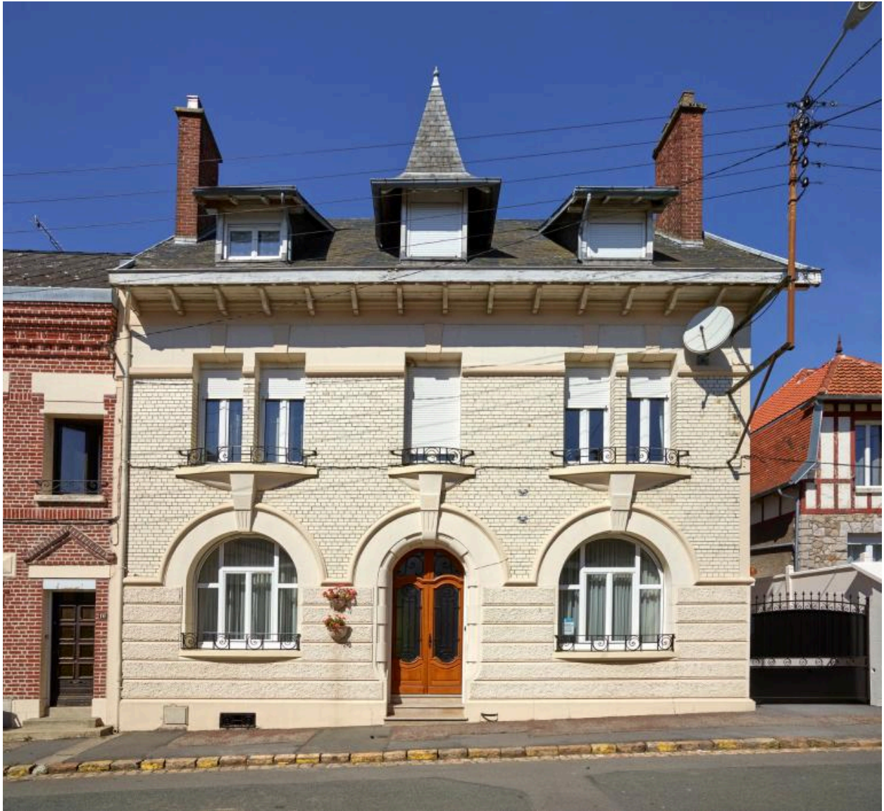
Vue générale de la façade principale.
