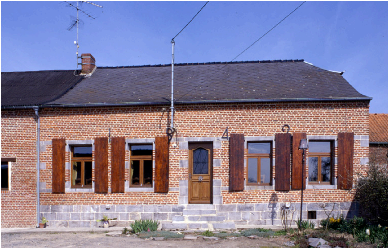
Façade du logis.
