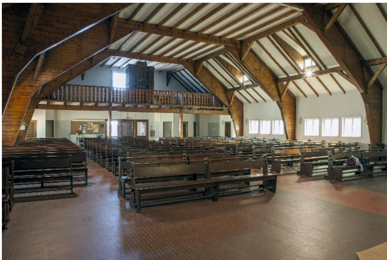
Vue générale de l'église depuis la partie droite du chœur.
