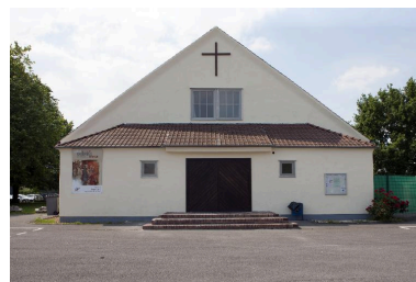
Élévation antérieure. Phot. Pierre Thibaut IVR31_20155900467NUCA
