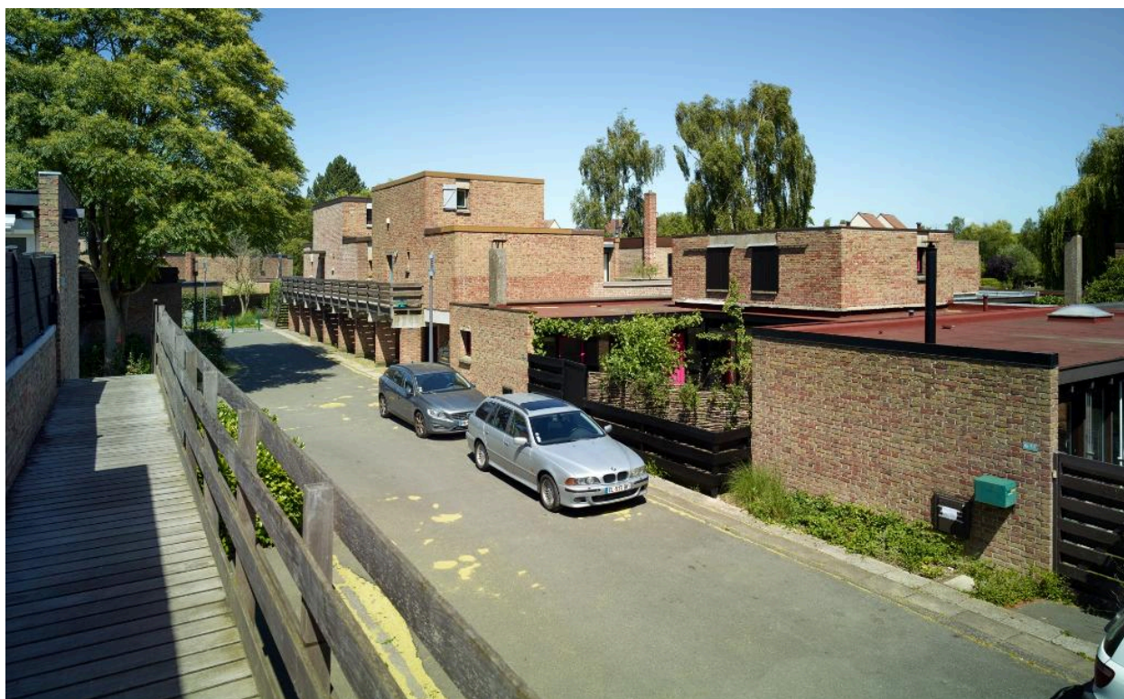
Volumes étagés du Hameau depuis une coursive, allée Chenonceaux.
