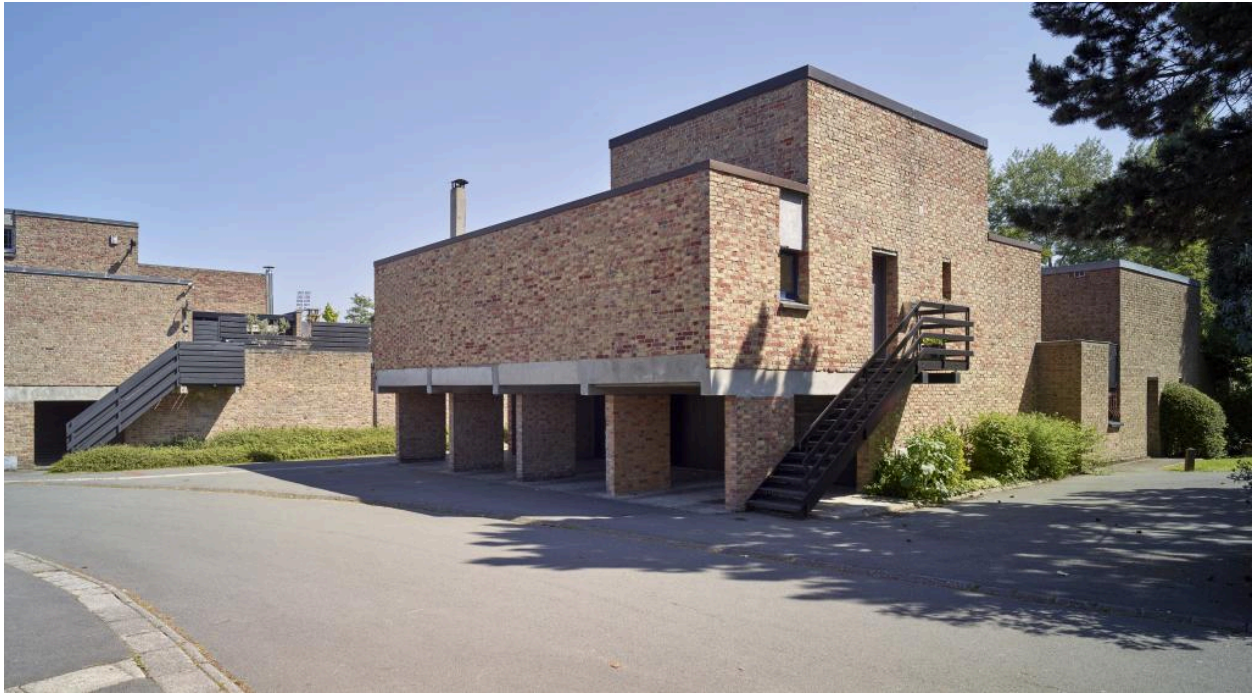
Allée Chenonceaux. Maison de plain-pied (au fond à droite) combinée à une maison sur garage qui rassemble les places de stationnement couvert.
