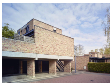
Maison sur garage avec patio en hauteur (à gauche) et maison de plain-pied avec étage (à droite). La combinaison des trois types de maisons donne une grande variété au Hameau. Phot. Pierre Thibaut IVR32_20185900059NUCA
