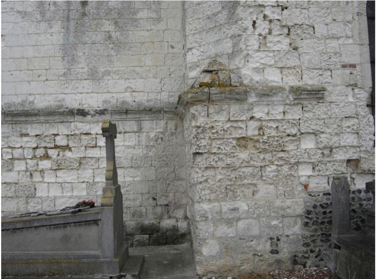
Vue partielle du mur nord dont la maçonnerie est littéralement attaquée par l'érosion éolienne.
