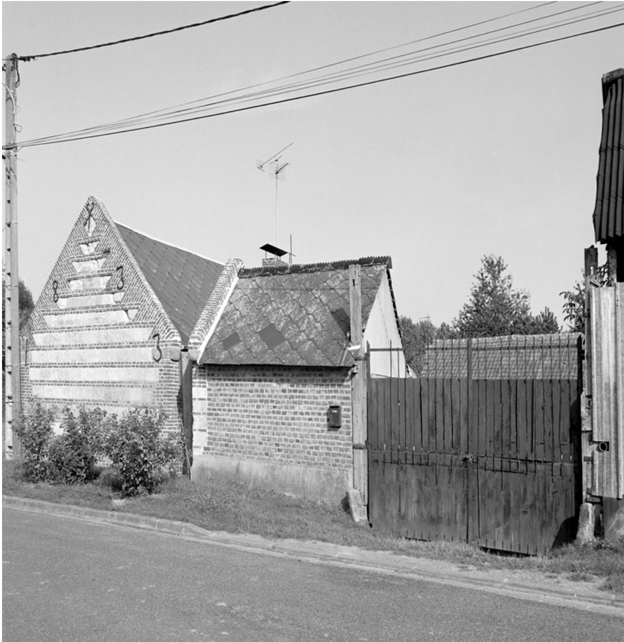
Vue d'ensemble, sur rue.
