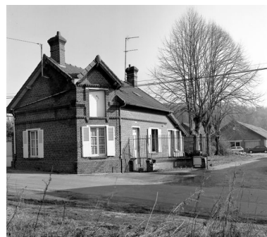
La conciergerie située à l'entrée de l'usine.
