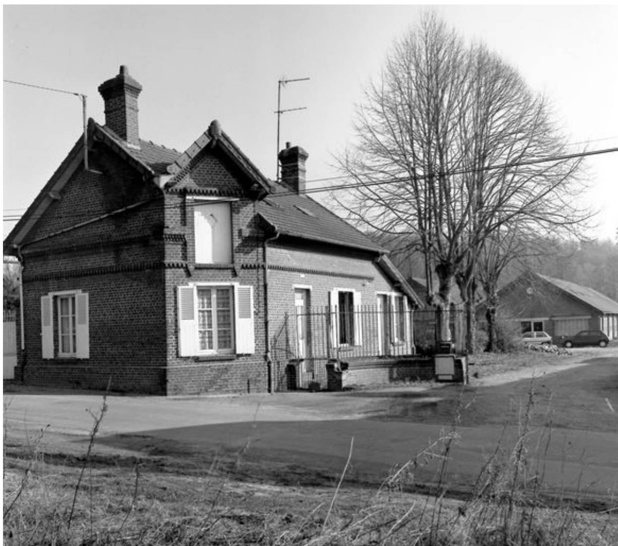
La conciergerie située à l'entrée de l'usine.
