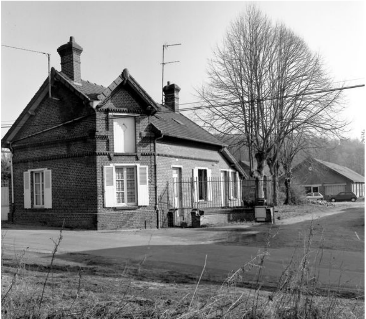
La conciergerie située à l'entrée de l'usine.
