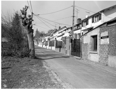
La cité ouvrière. Phot. Laurent Jumel IVR22_19966000040X
