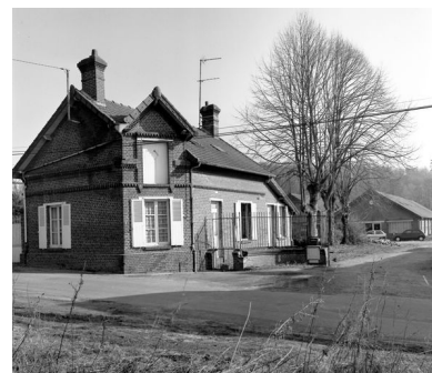
La conciergerie située à l'entrée de l'usine.
