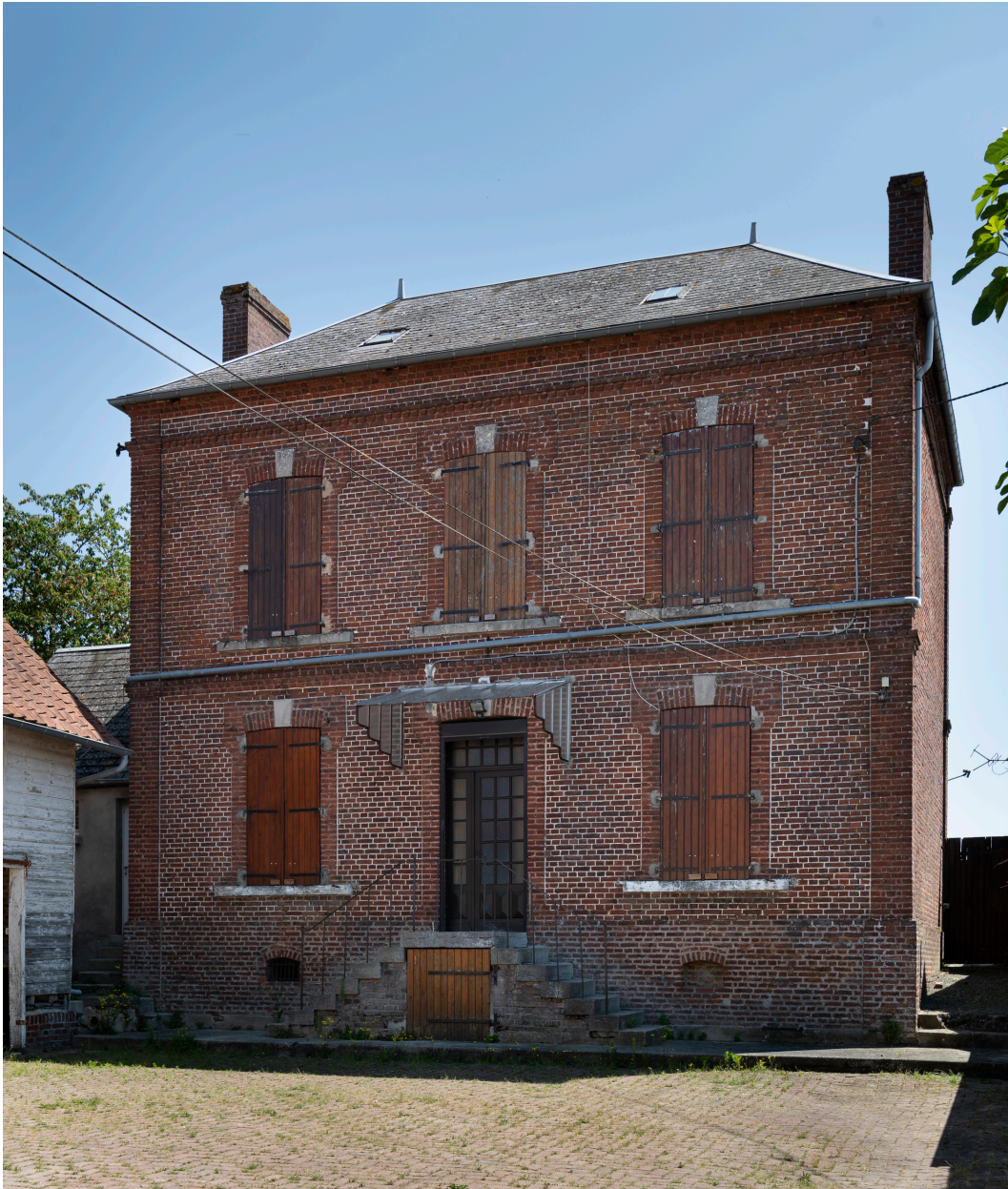
Ancienne mairie et logement de l'instituteur, n°25 de la rue de l'École, vue depuis l'ouest.
