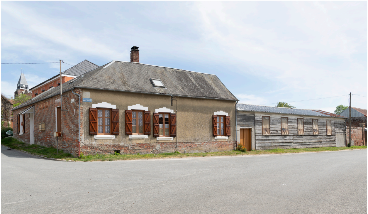
Ancien café et salle de bal (bâtiment essenté en bois à droite), angle des rues Marcel-Dassault et de l'École.
