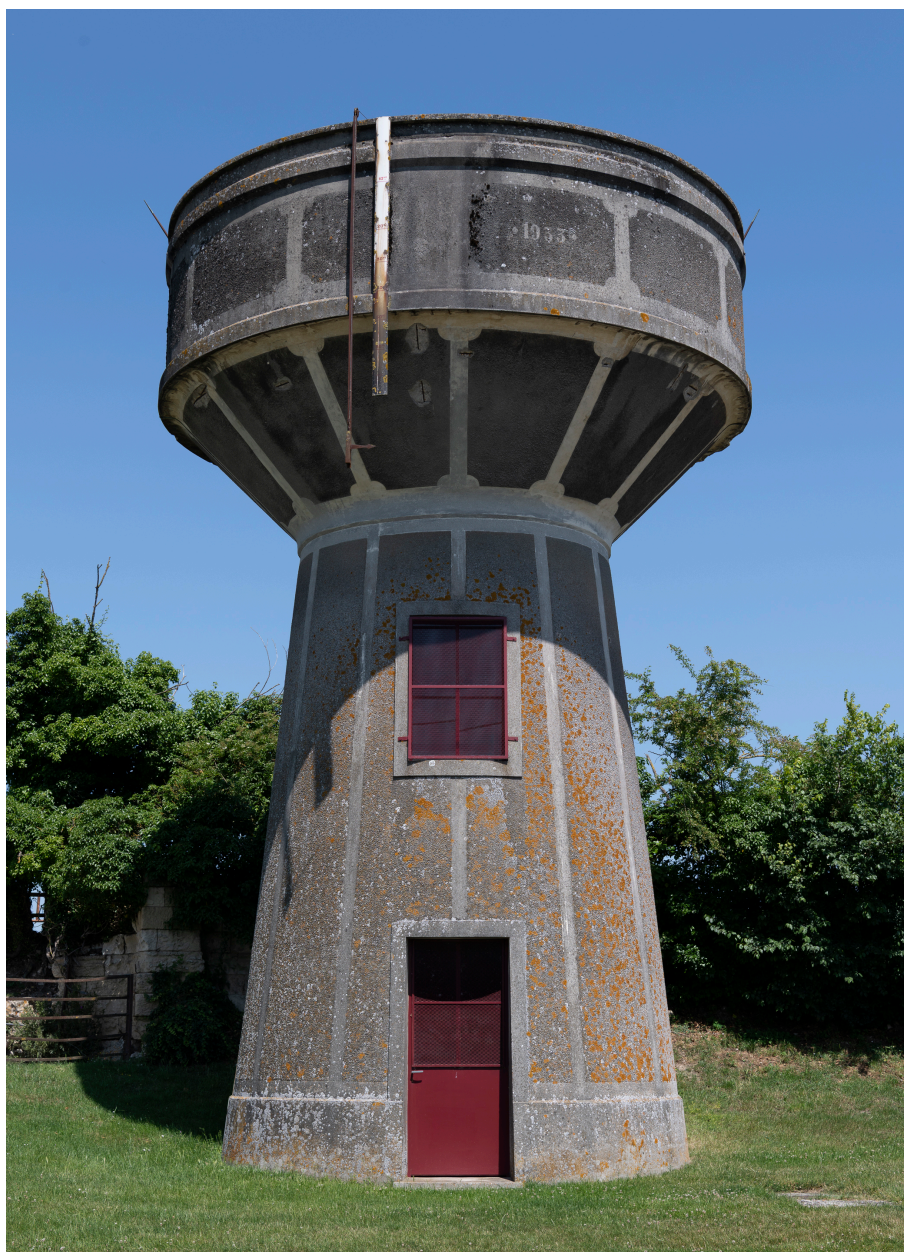
Château d'eau, rue Neuve, vue depuis le sud.
