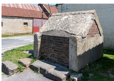
Ancien puits, rue du Mesnil, vue depuis le sud-ouest. Phot. Marc Kérignard IVR32_20256000375NUCA
