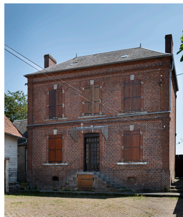
Ancienne mairie et logement de l'instituteur, n°25 de la rue de l'École, vue depuis l'ouest. Phot. Marc Kérignard IVR32_20256000371NUCA
