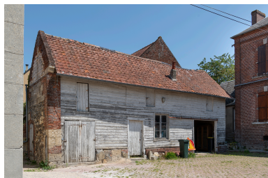
Bâtiments de l'ancienne mairie, n°25 de la rue de l'École, vue depuis le sud-ouest. Phot. Marc Kérignard IVR32_20256000372NUCA
