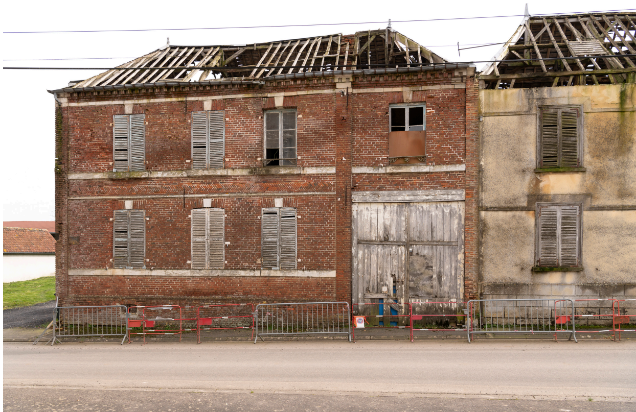
Demeure, n°3 de la rue Fournier, vue prise depuis le nord.
