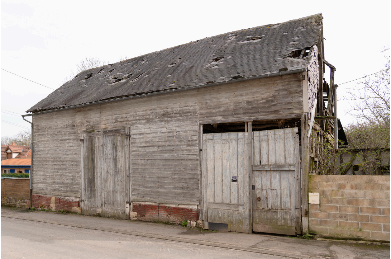
Grange sur rue essentée de bois, n°18 de la rue Poncelet, vue prise depuis le nord.
