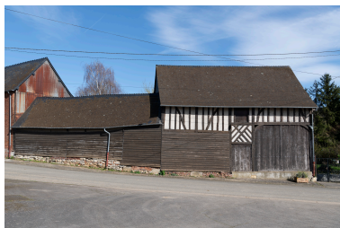
Grange et bâtiment agricole sur rue, n°22 de la rue Martin, vue prise depuis le sud. Phot. Marc Kérignard IVR32_20246000118NUCA
