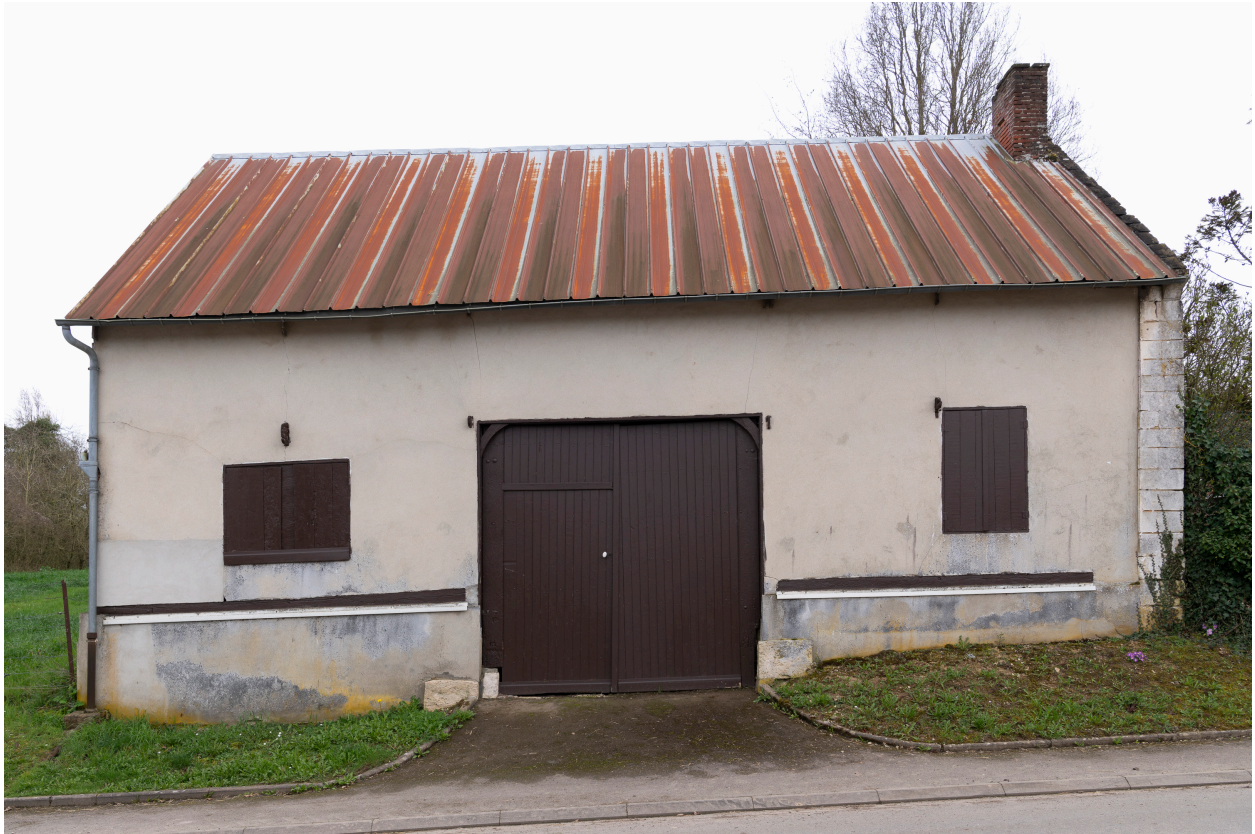
Bâtiment sur rue avec boutique, porte charretière et grange, rue Fournier, vue prise depuis le nord.
