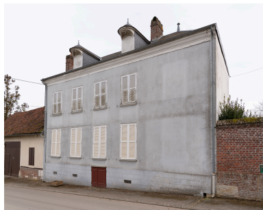
Demeure de notable, n°25 rue Fournier, vue prise depuis le nord. Phot. Marc Kérignard IVR32_20246000135NUCA
