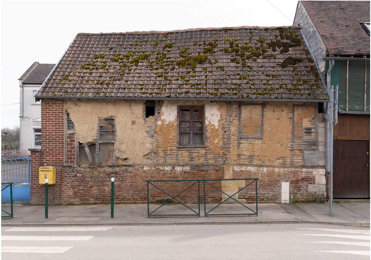
Ancien logis en pans de bois et torchis, n°6 de la rue Poncelet, vue prise depuis le nord.
