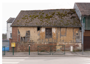
Ancien logis en pans de bois et torchis, n°6 de la rue Poncelet, vue prise depuis le nord. Phot. Marc Kérignard IVR32_20246000123NUCA
