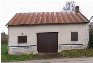
Bâtiment sur rue avec boutique, porte charretière et grange, rue Fournier, vue prise depuis le nord. Phot. Marc Kérignard IVR32_20246000133NUCA
