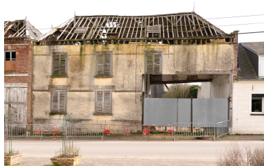
Demeure en pans de bois et torchis, n°5 de la rue Fournier, vue prise depuis le nord. Phot. Marc Kérignard IVR32_20246000131NUCA
