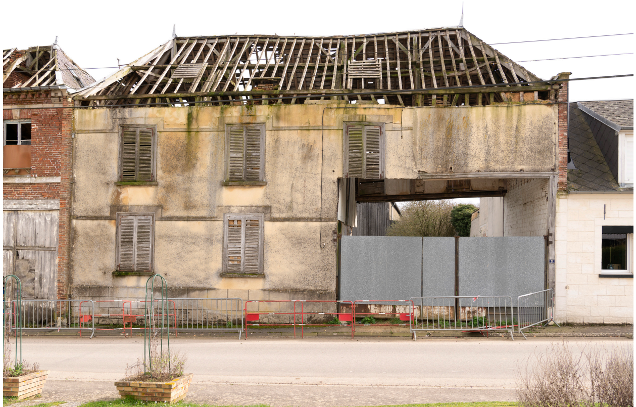
Demeure en pans de bois et torchis, n°5 de la rue Fournier, vue prise depuis le nord.
