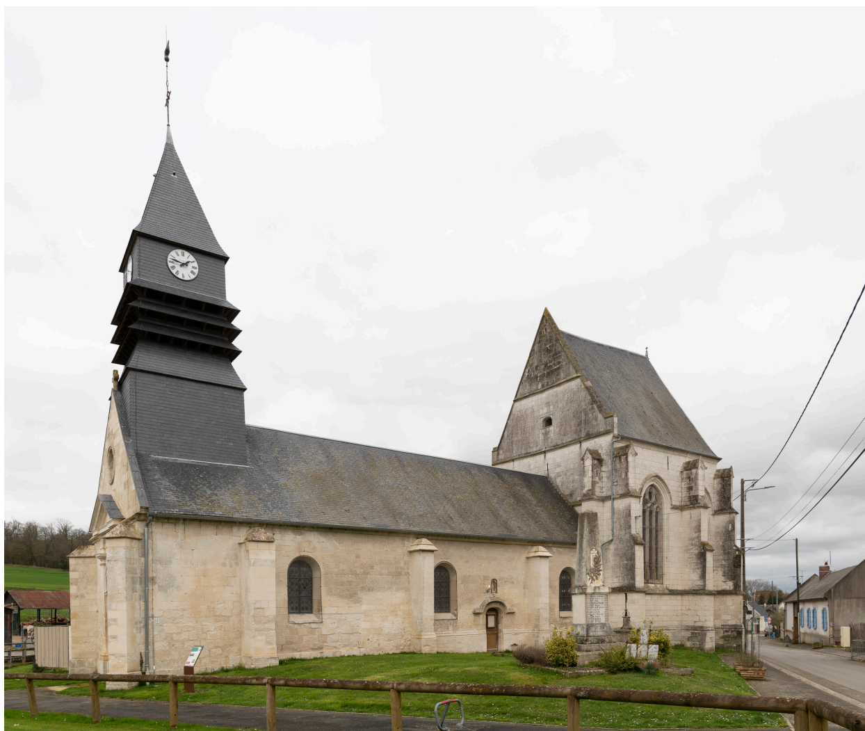
Vue générale depuis le sud-ouest.
