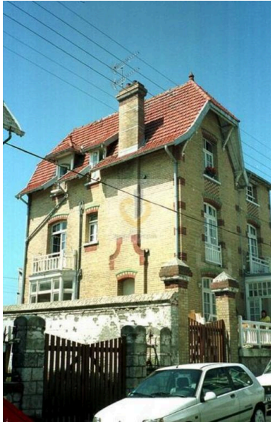
Vue générale. Phot. Richard Klein IVR31_19966201489ZE
