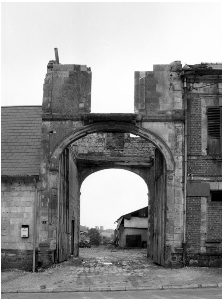
Vue de la façade du pigeonnier porche.
