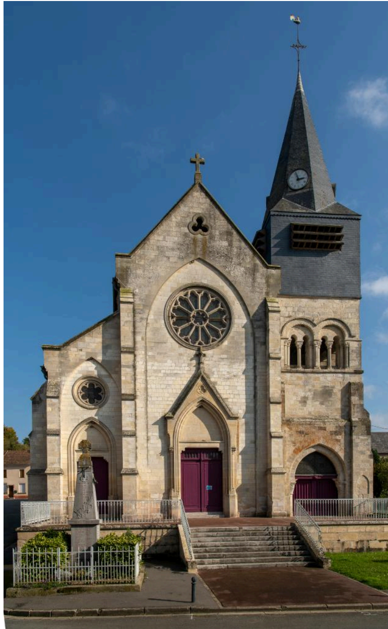
Vue générale de la façade occidentale.
