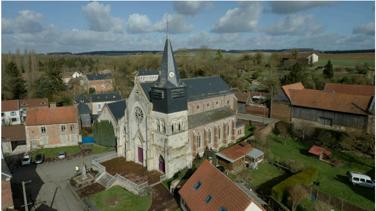
Vue aérienne de l'église depuis le sud-ouest.
