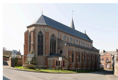
Vue du chevet et de l'élévation nord. Phot. Marc Kérignard IVR32_20226000161NUCA
