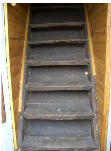
Escalier d'accès au grenier pratiqué dans la façade. Phot. Inès Guérin IVR22_20078005148NUCA
