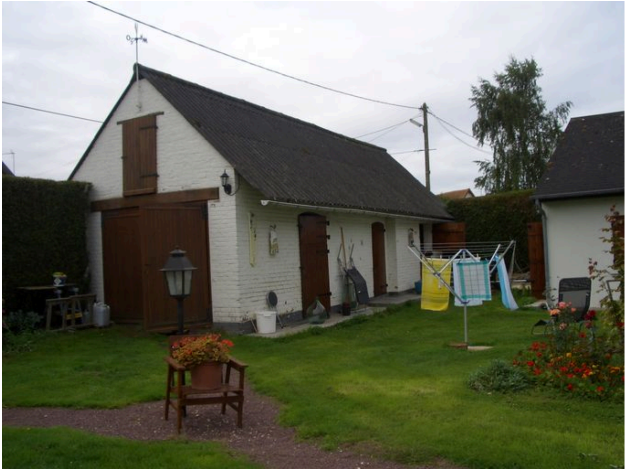
Vue des écuries sur rue.
