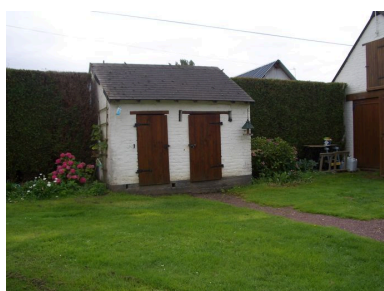
Vue des étables à cochons sur rue. Phot. Inès Guérin IVR22_20078005150NUCA
