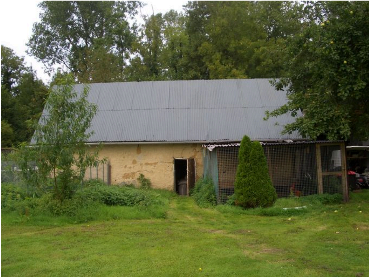
Vue de la grange en fond de propriété.
