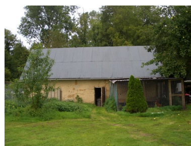
Vue de la grange en fond de propriété. Phot. Inès Guérin IVR22_20078005152NUCA
