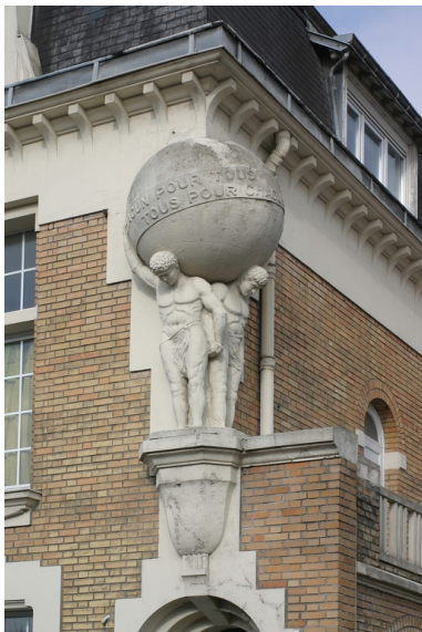
Immeuble de 1928, détail. Phot. Frédéric Pillet IVR22_20050205789NUCA
