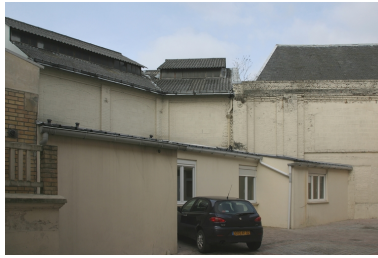
Vue de l'ancienne fonderie depuis la cour. Phot. Frédéric Pillet IVR22_20050205787NUCA
