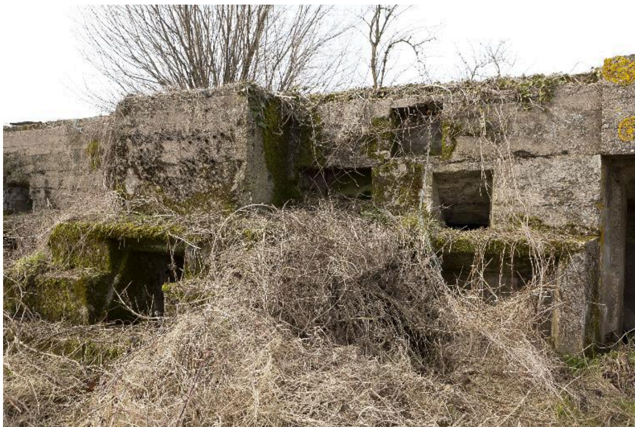
Banquette de tir. En bas, à gauche, la resserre à la mitrailleuse. Au centre, les niches à munitions. A droite, l'entrée latérale nord-est
