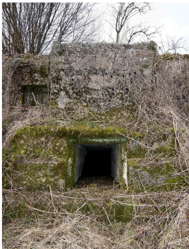
Resserre à mitrailleuse Phot. Jean-Marc Ramette IVR31_20145904548NUCA
