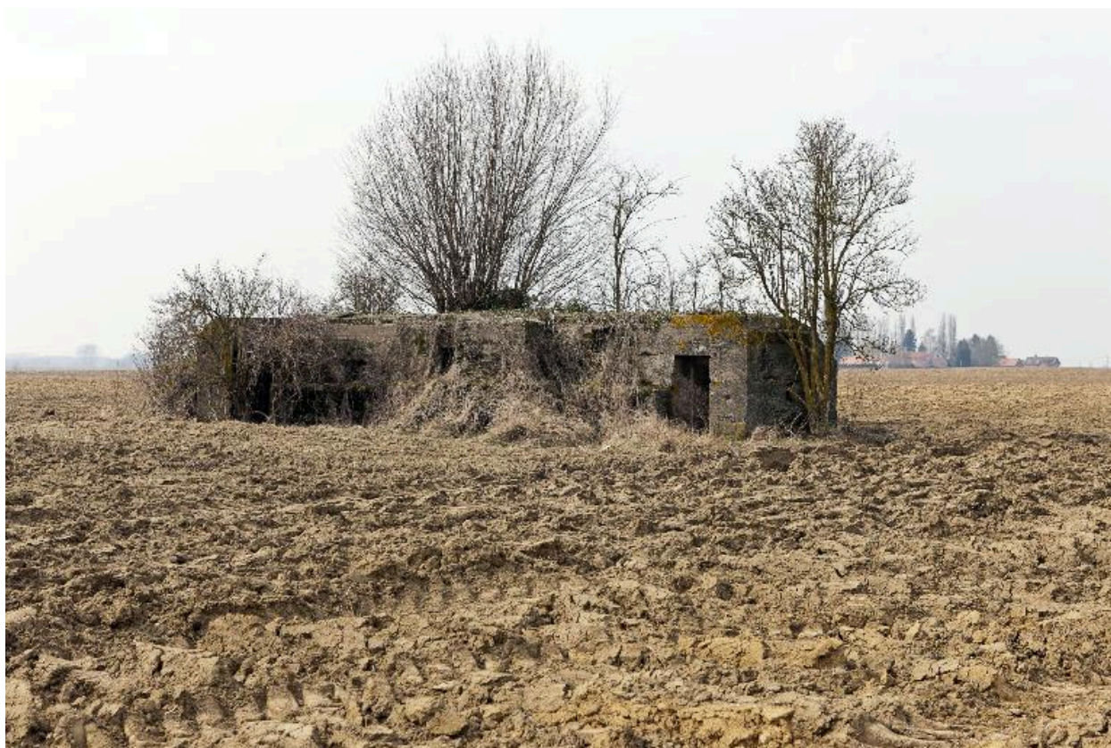
Vue vers le nord-ouest
