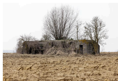
Vue vers l'ouest Phot. Jean-Marc Ramette IVR31_20145904514NUCA
