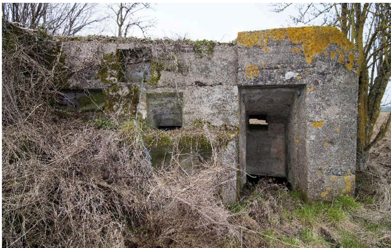
Niches à munition et entrée latérale nord-est
