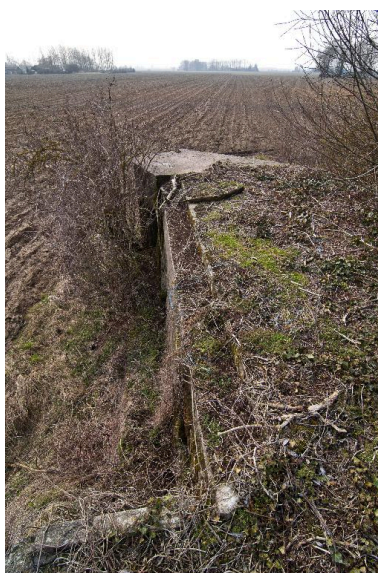
Depuis le couvrement, vue vers le sud-ouest Phot. Jean-Marc Ramette IVR31_20145904545NUCA
