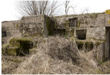
Banquette de tir. En bas, à gauche, la resserre à la mitrailleuse. Au centre, les niches à munitions. A droite, l'entrée latérale nord-est Phot. Jean-Marc Ramette IVR31_20145904534NUCA
