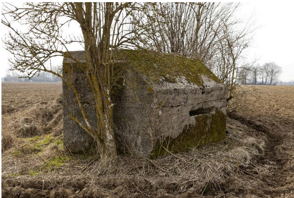
Vue latérale, vers le sud-ouest
