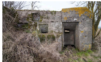
Niches à munition et entrée latérale nord-est Phot. Jean-Marc Ramette IVR31_20145904550NUCA
