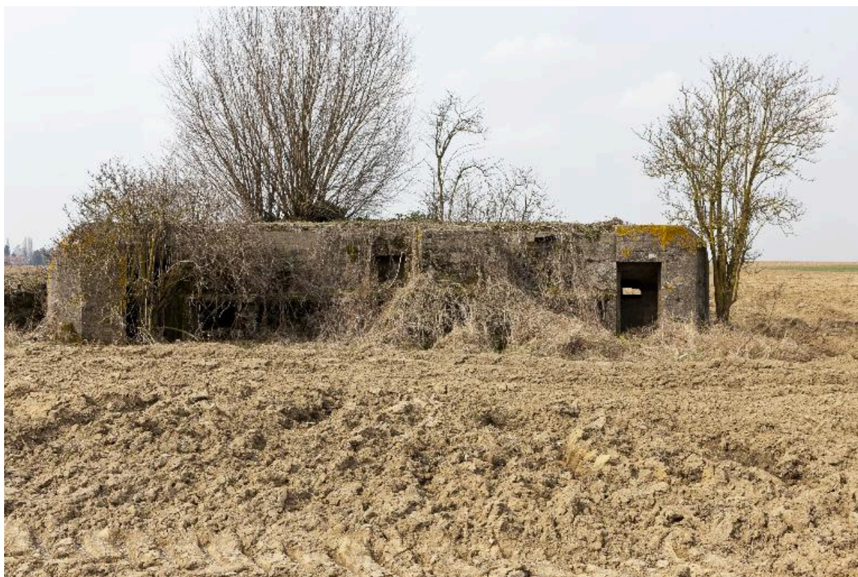
Vue vers le nord-ouest
