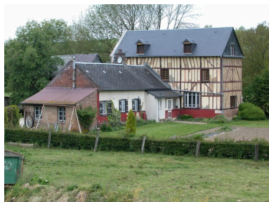
Vue d'ensemble. Phot. Bertrand Fournier IVR22_20056000791NUCA
