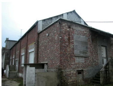
Vue de trois quarts sur les élévations postérieure et latérale droite. Phot. Elisabeth Justome IVR22_20048001531NUCA
