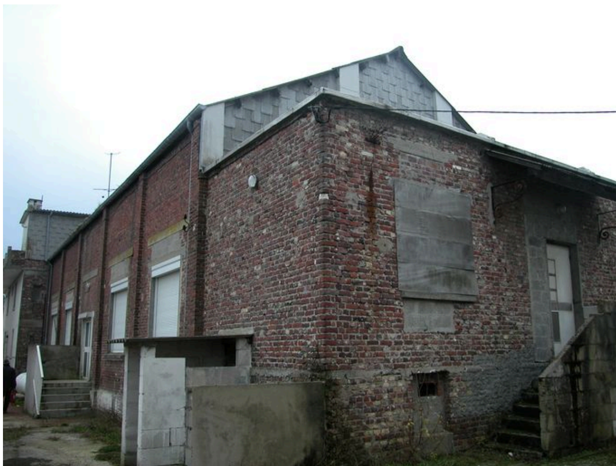
Vue de trois quarts sur les élévations postérieure et latérale droite.
