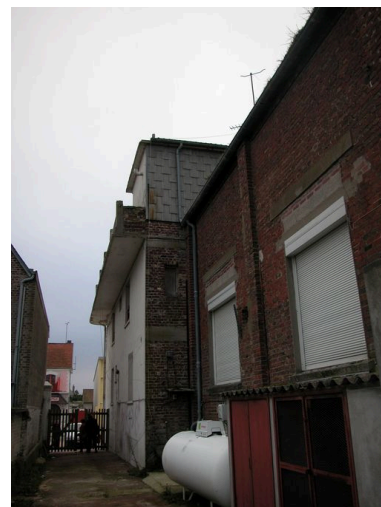
Élévation latérale droite. Phot. Elisabeth Justome IVR22_20048001532NUCA
