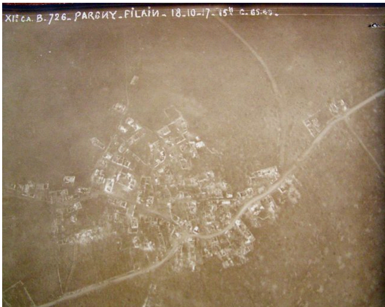
Vue aérienne du village en 1917.
