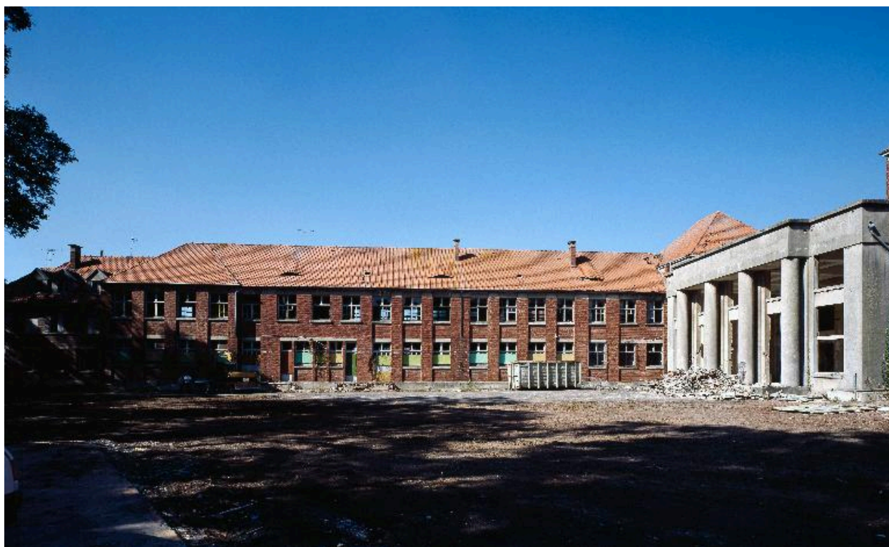
Façade postérieure, avenue Danicourt.
