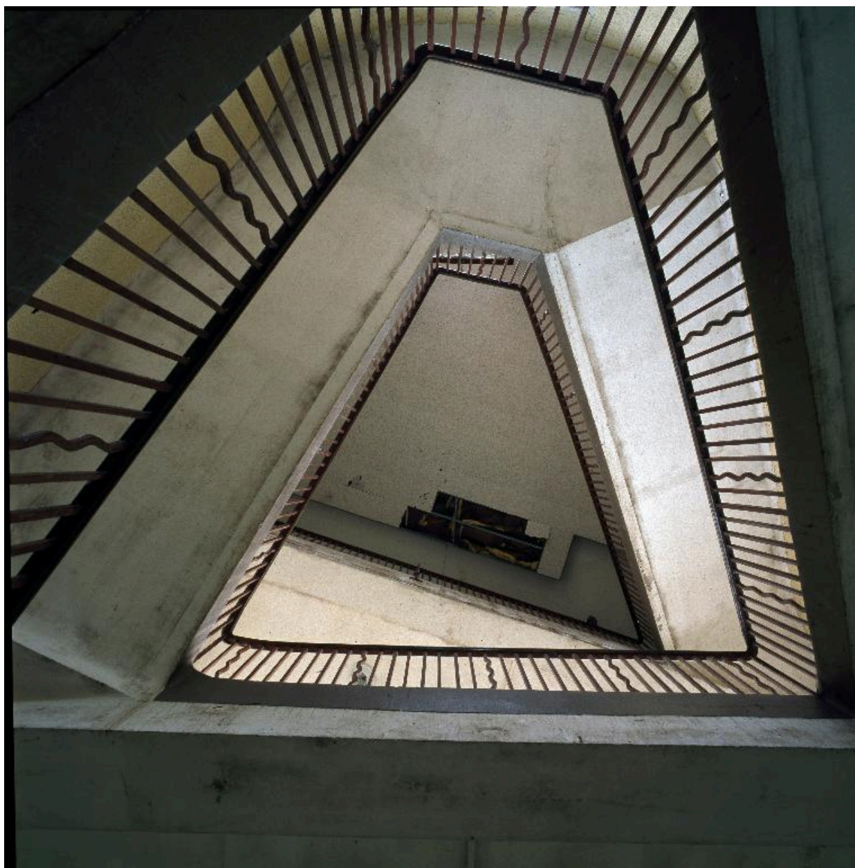
Vue de la cage d'escalier.
