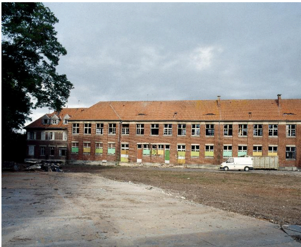
Façade postérieure, avenue Danicourt.
