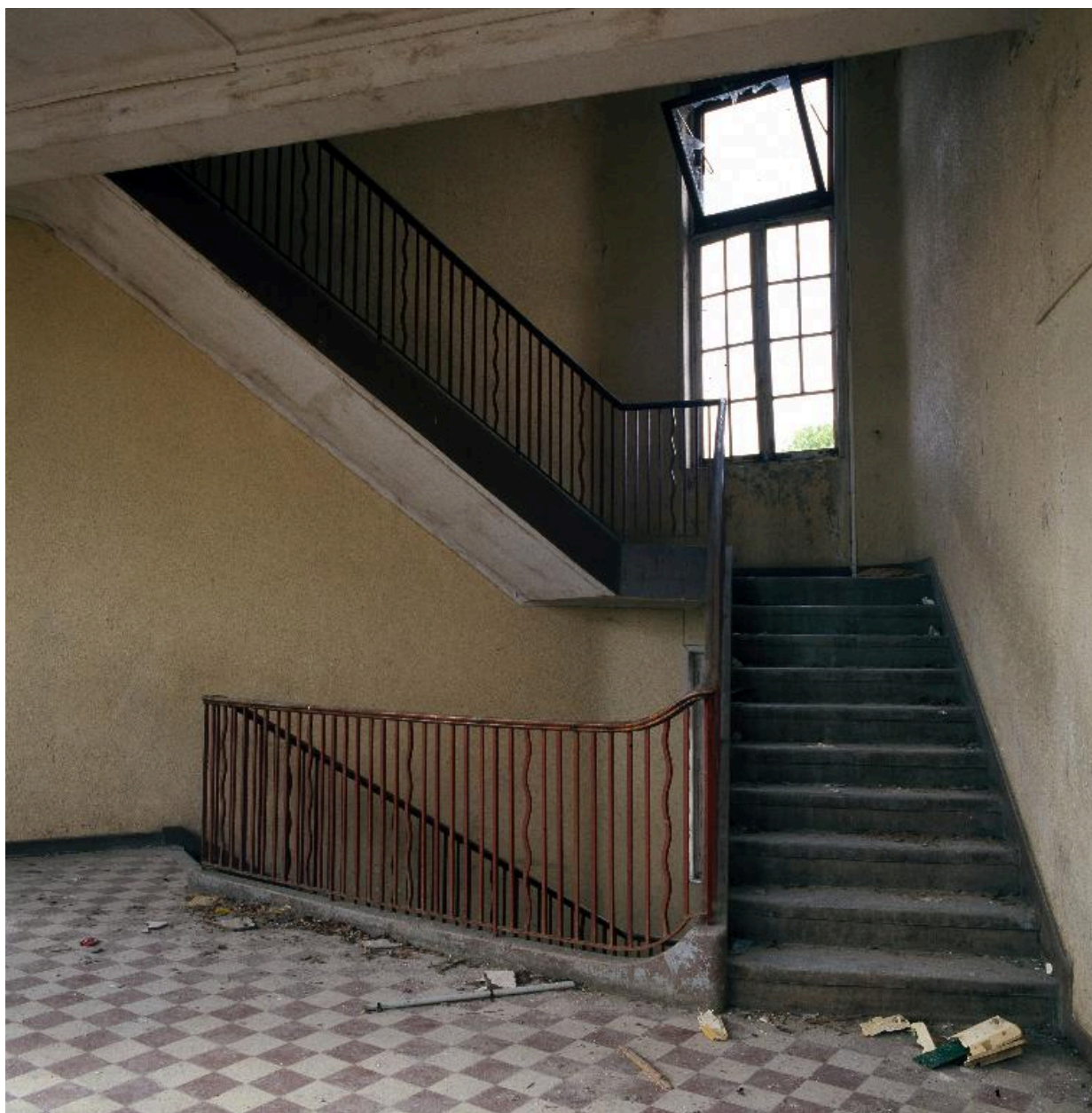
Vue de l'escalier.
