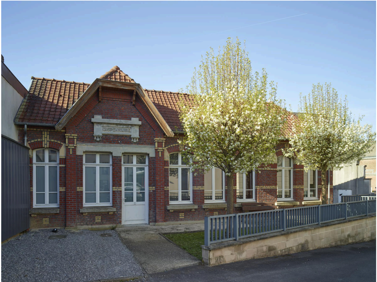
Ancien dispensaire : façade sur la cour de la maison de retraite.
