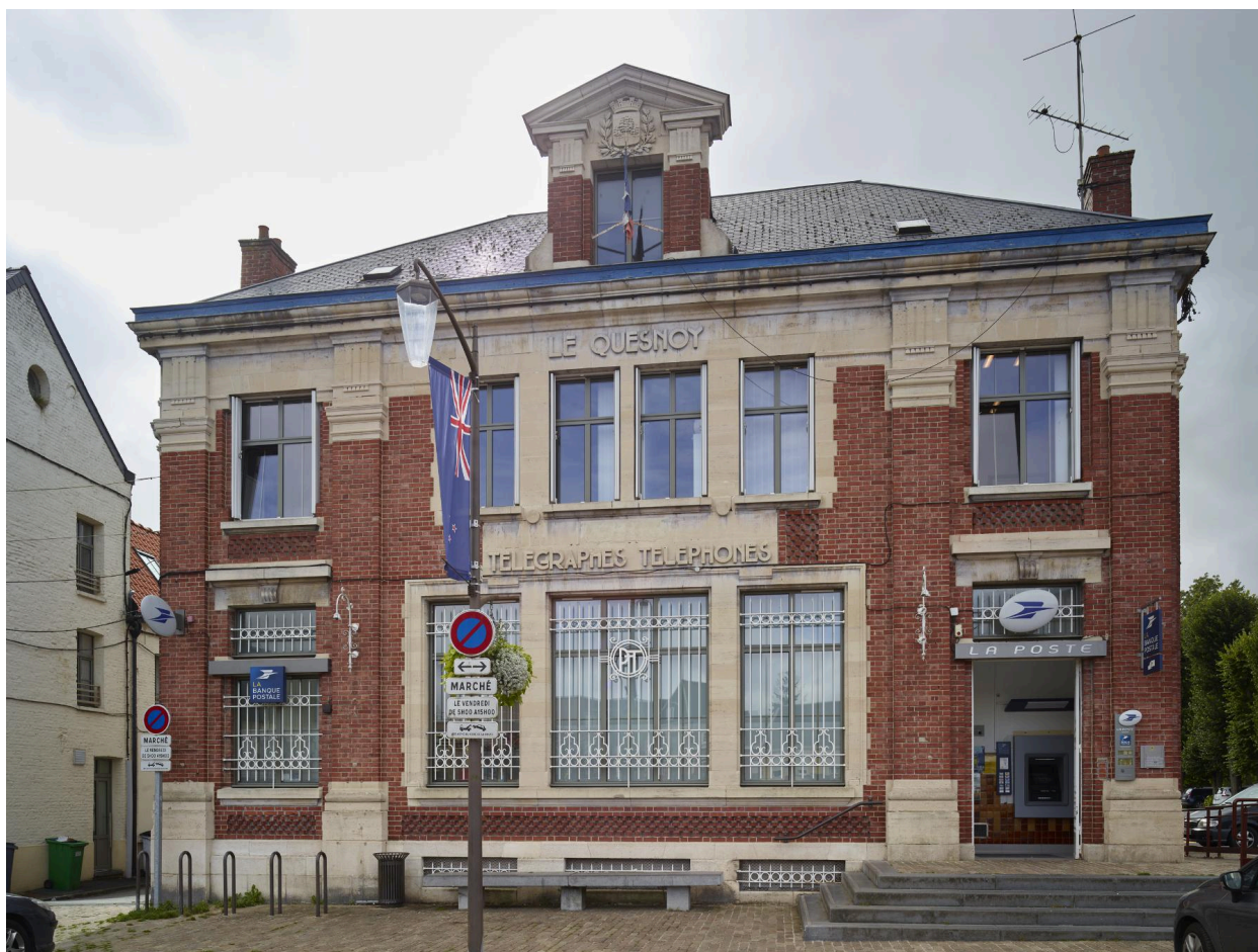
Poste : façade principale sur la place du Général-Leclerc.
