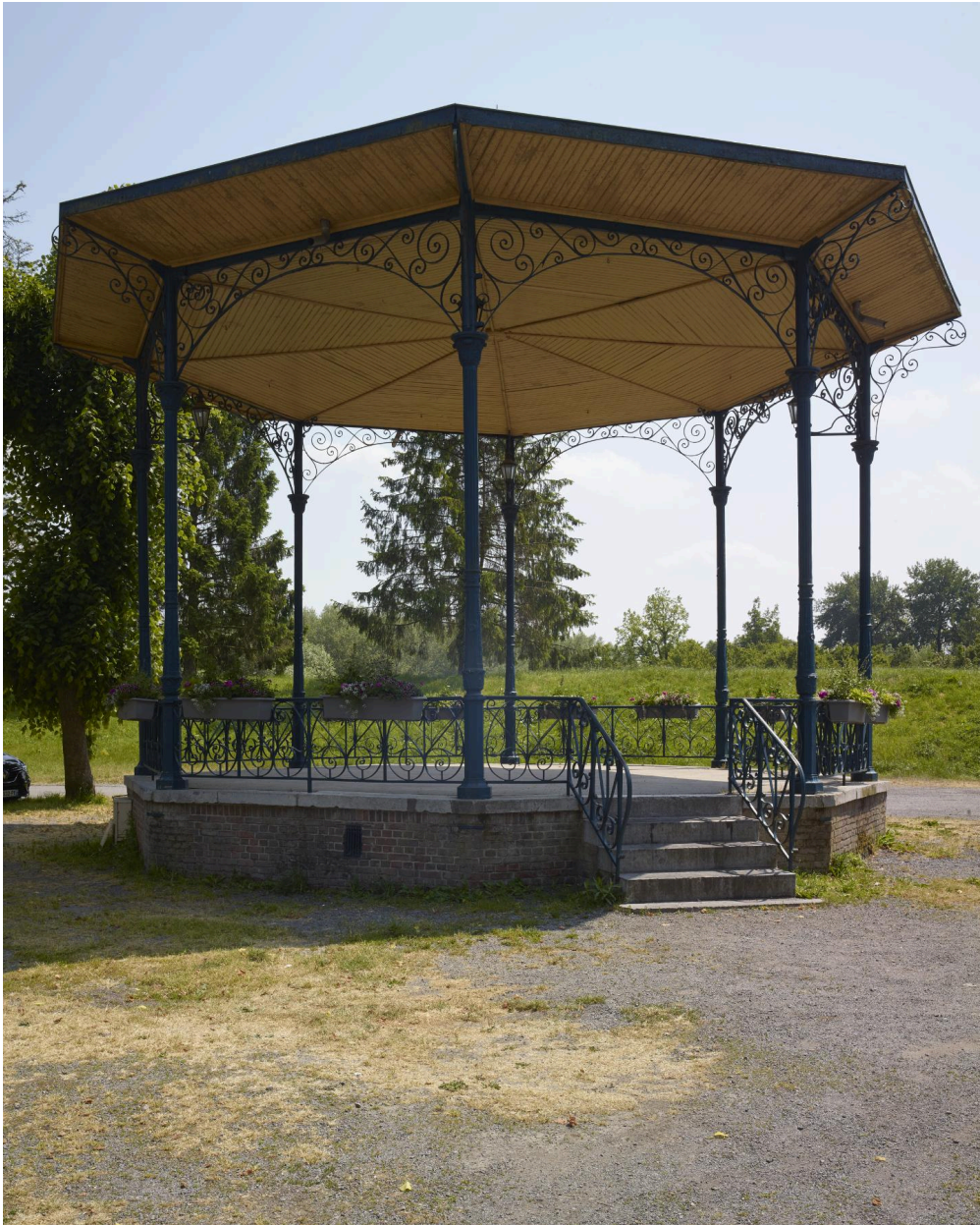
Kiosque à musique : vue générale, orientée sud-nord.
