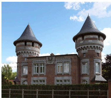
Vue de détail de la façade principale, sur rue.
