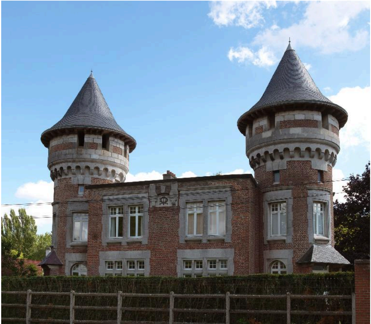
Vue de détail de la façade principale, sur rue.
