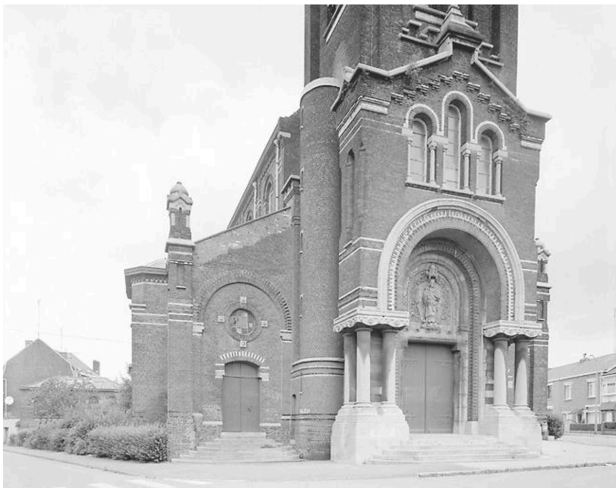
Façade ouest, vue partielle : 1er niveau, vue de trois quarts gauche.
