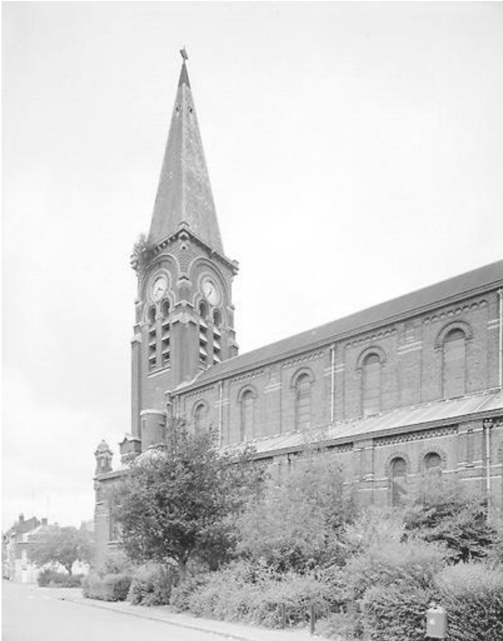
Élévation latérale sud, vue partielle en regardant vers l'ouest.
