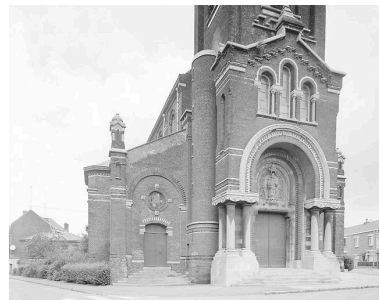
Façade ouest, vue partielle : 1er niveau, vue de trois quarts gauche. Phot. Pierre Thibaut IVR31_20055900982V
