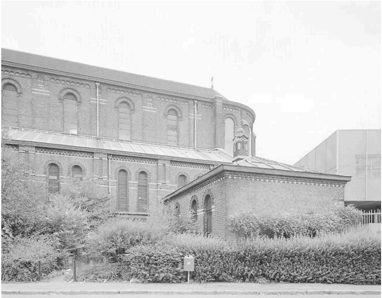
Elévation latérale sud, vue partielle en regardant vers l' est.
