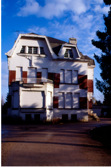
Élévation antérieure. Phot. Olivier Marlard IVR31_19955901133ZA
