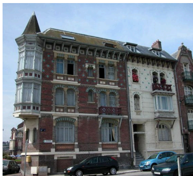
Vue d'ensemble depuis la rue Sadi-Carnot. Phot. Elisabeth Justome IVR22_20038005289NUCA
