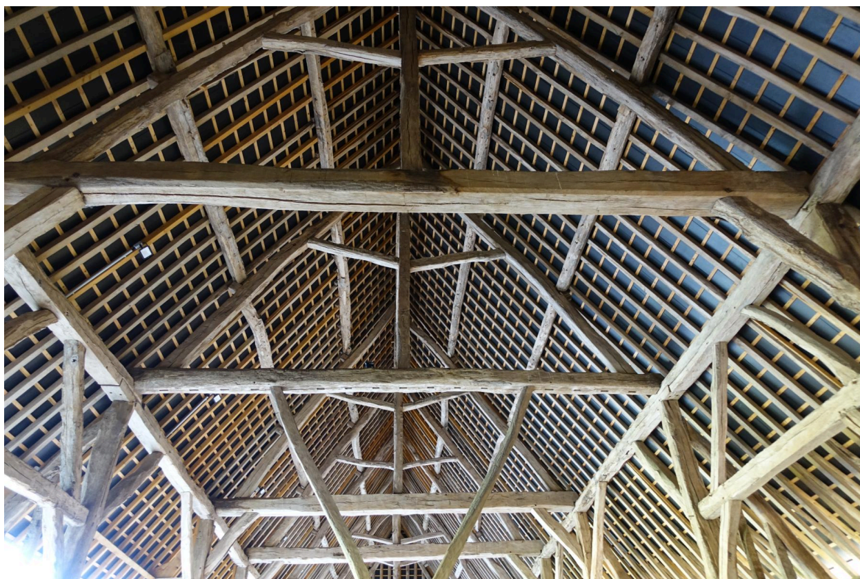
Charpente de l'ancienne grange et pressoir.
