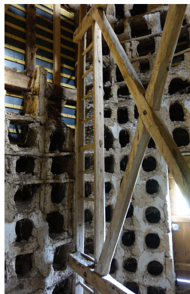
Intérieur du pigeonnier : boulins et échelle tournante. Phot. Lucile Chamignon IVR32_20226005100NUCA
