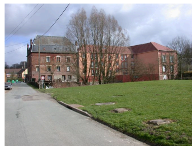
Vue générale. Phot. Bertrand Fournier IVR22_20026000785NUCA
