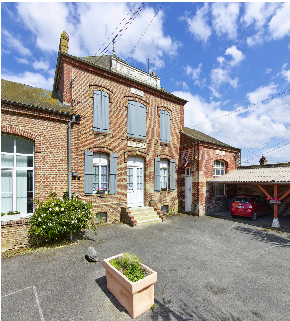
Ancien logement de l'instituteur, depuis l'ouest.
