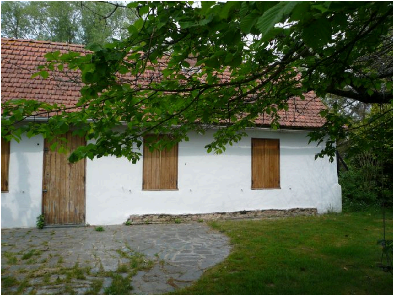
Vue d'une partie du logis.
