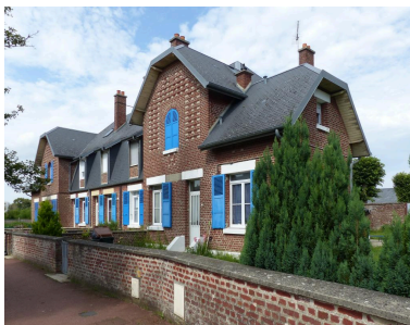
Les logements, rue Poulin. Phot. Isabelle Barbedor IVR32_20218005203NUCA
