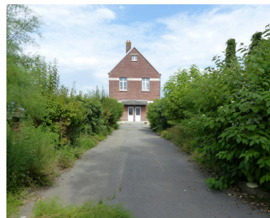
L'accès nord, depuis la rue Poulin. Phot. Isabelle Barbedor IVR32_20218005204NUCA
