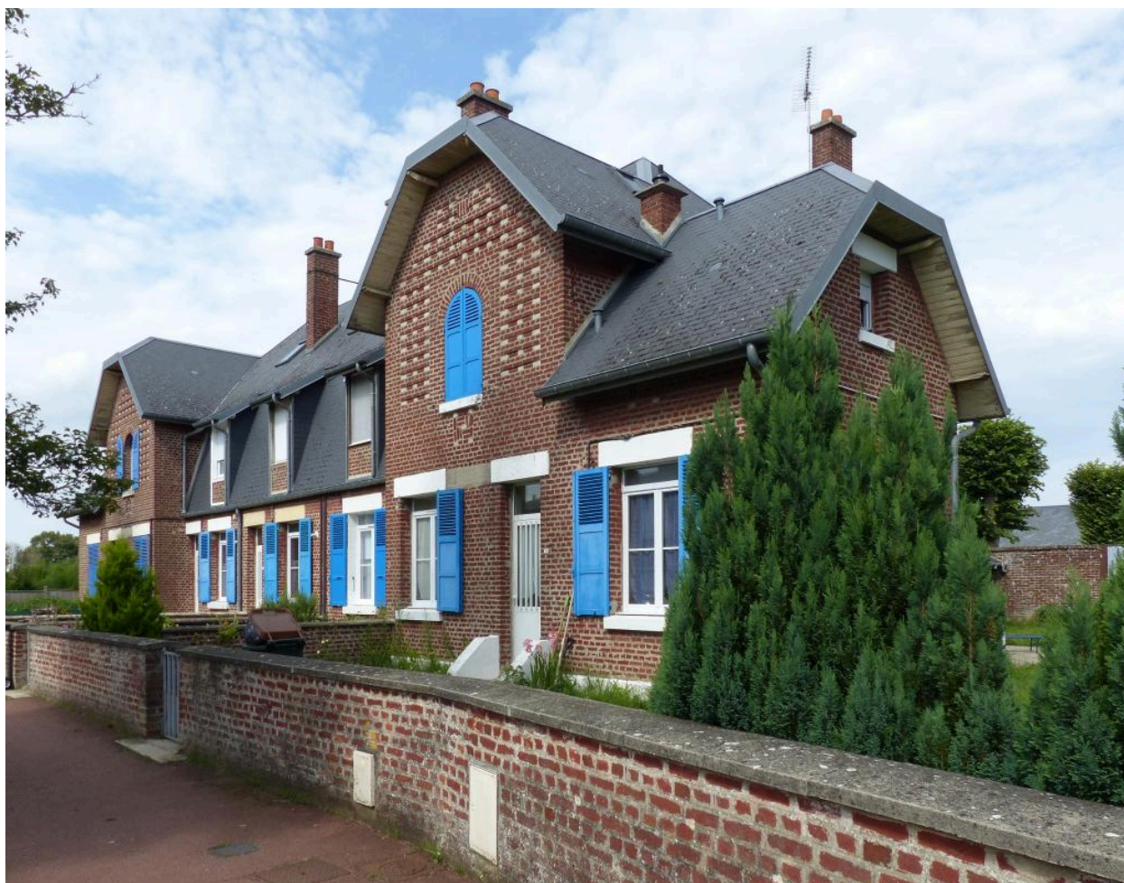
Les logements, rue Poulin.
