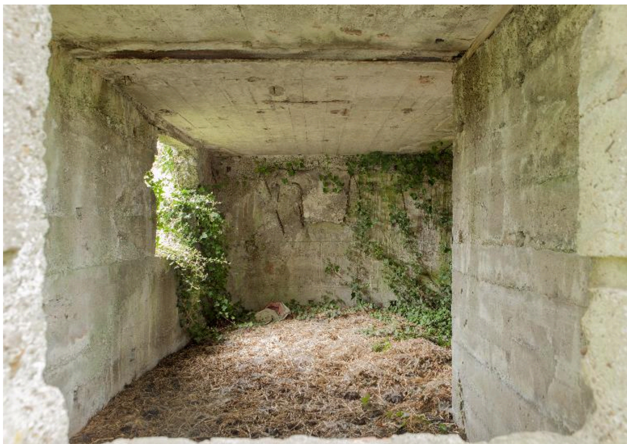
Casemate a), seconde salle en enfilade
