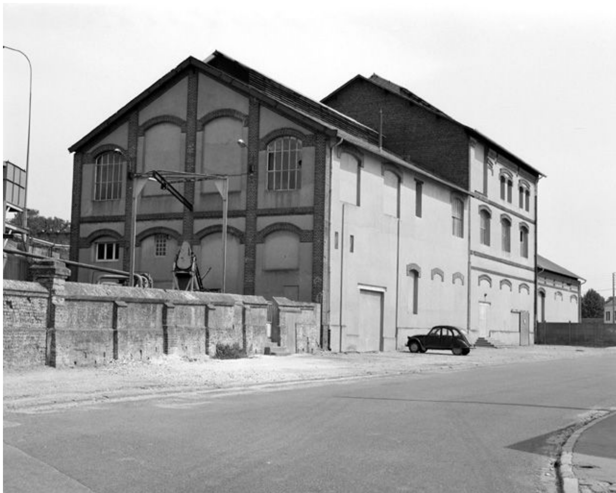
Râperie, flanc sud-ouest.
