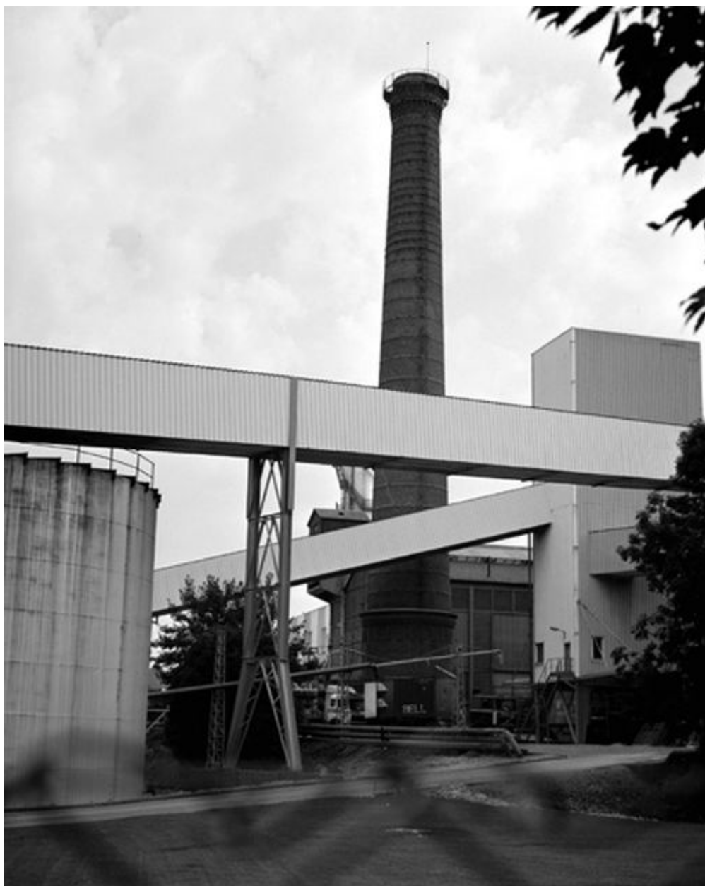
Vue de la cheminée d'usine.
