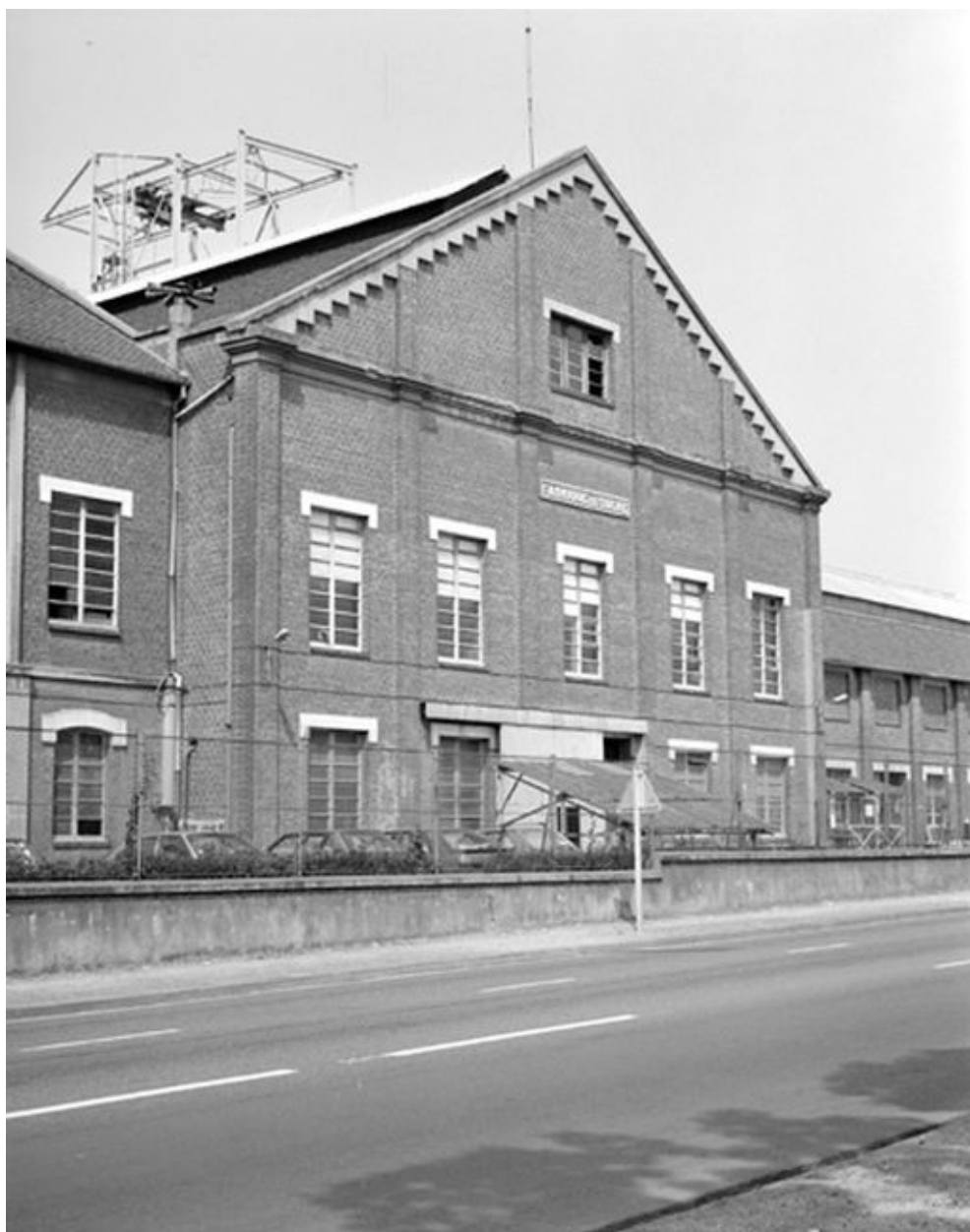
Atelier de fabrication, vue partielle, flanc est.
