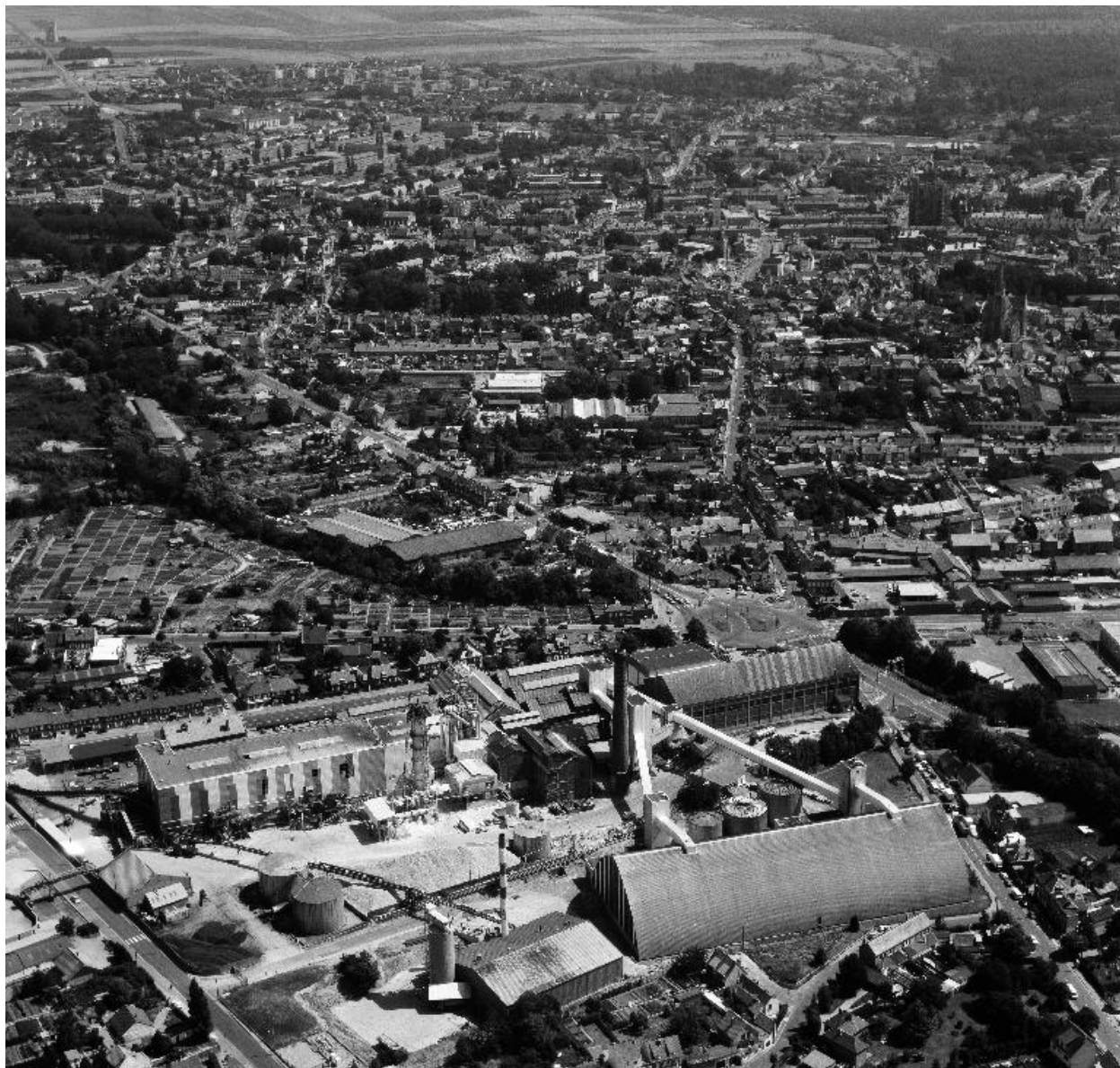
Vue aérienne de 1990, flanc nord.
